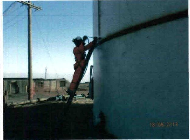
**FOTO N°02:** En la fotografía se muestra el preciso instante de ubicación de puntero por nuestro personal NDT.
