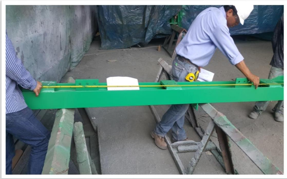
*Figura 36:* control dimensional de la viga
