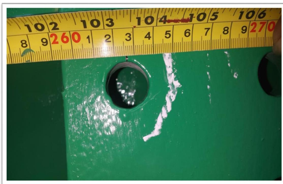
**Figura 35:** Viga (DP1-BTNS-M5-V137\_1), desfase de agujero
