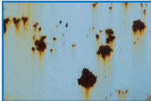
**FIGURA N° 22: CORROSIÓN INTERNA**
