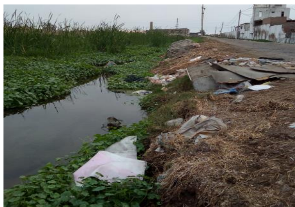
Zonas del canal el agua corre con normalidad
