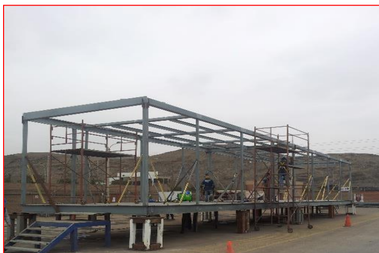
Figura 6.1: Instalación de estructuras para paredes
