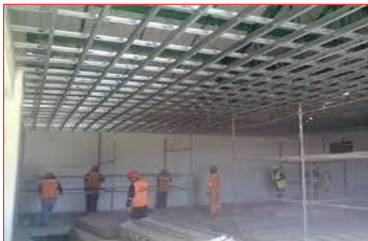
Figura 7.1: instalación de cielo raso
