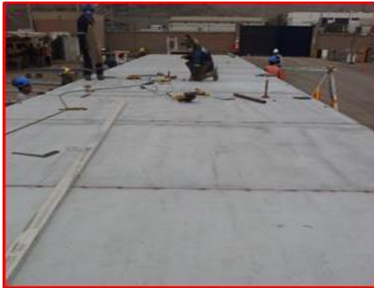
Figura 5.2: Instalación de Plancha Piso
