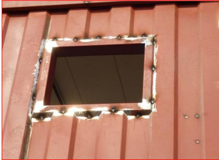
Figura 9.1: instalación de Cuellos de Paredes
