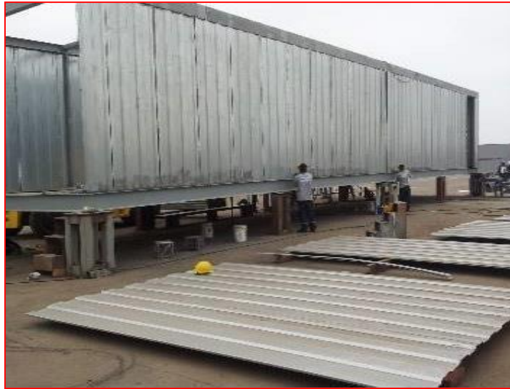
Figura 6.2: Instalación de Paredes
