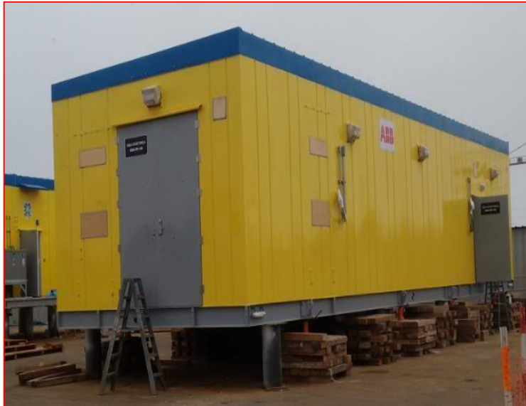
Figura 10.1: Acabado de Pintura
