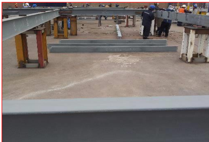
Figura 3.1: Armado de Plataforma
