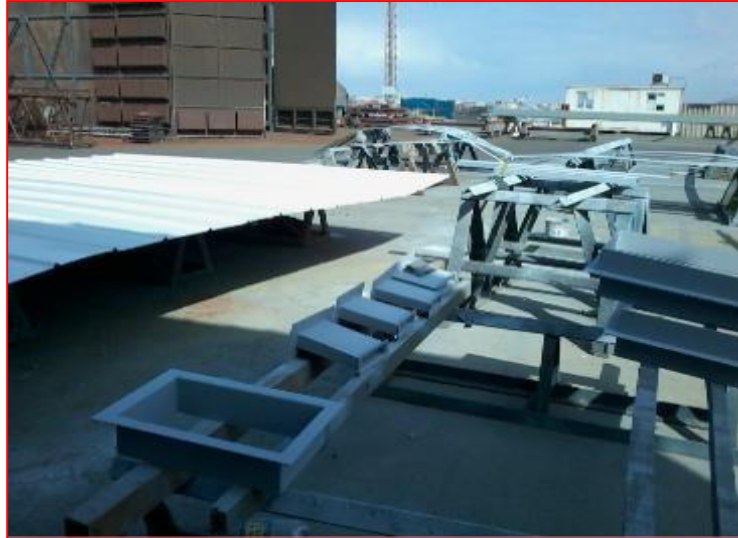
Figura 1.1: Habilitado de Materiales
