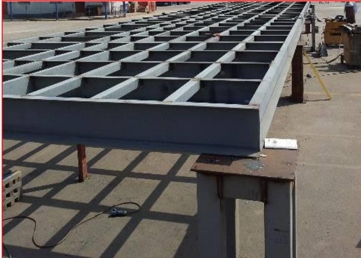
Figura 3.2: Armado de Plataforma
