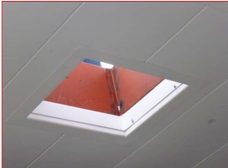
Figura 9.2: instalación de Cuellos de Techo
