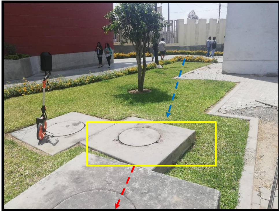
Figura 3.28 Fibra óptica llegó a buzón número 4 mediante canalizado proyectado. Fuente: Proveedor de internet, 2019
