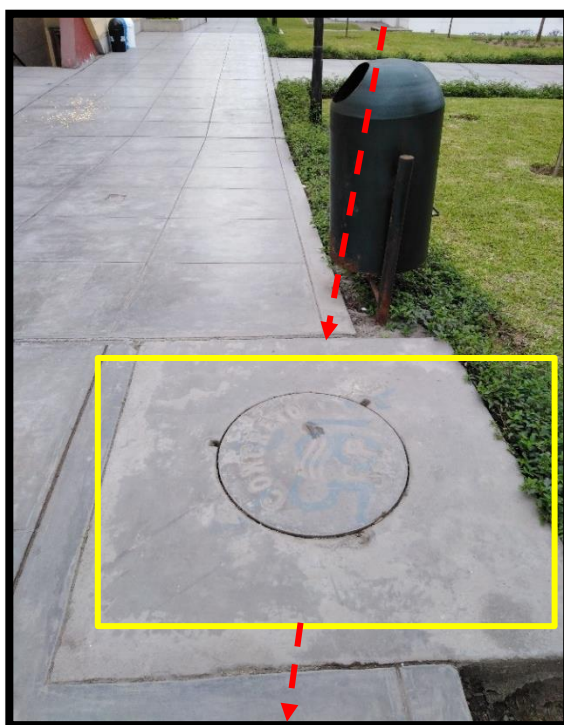
Figura 3.29 Fibra óptica llegó a buzón número 5 mediante canalizado proyectado Fuente: Proveedor de internet, 2019
