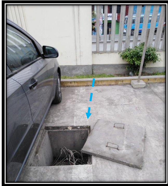
Figura 3.18 Inicio de canalizado Fuente: Elaboración propia, 2019
