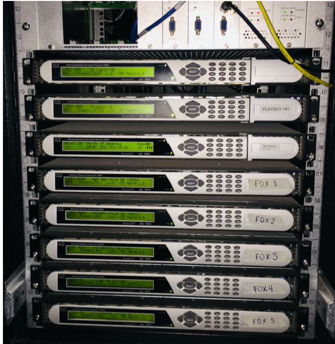
Figura 34: Implementación de decodificadores Cisco MPCM (Canal Múltiple por Operador) Fuente: elaboración propia
