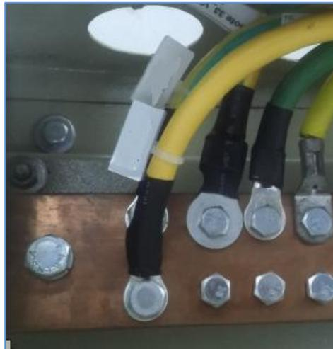
**Figura 3-26.** Punto de conexión en el lado de la barra de tierra con espacio libre
