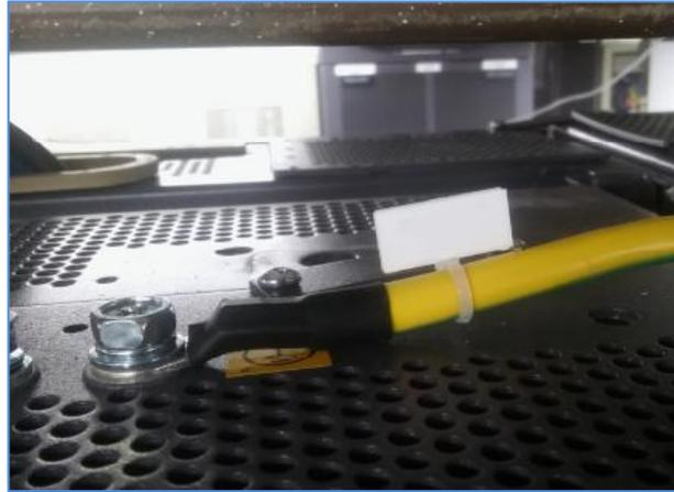
**Figura 3-25.** Punto de conexión en la parte superior del bastidor OSN HUAWEI.
