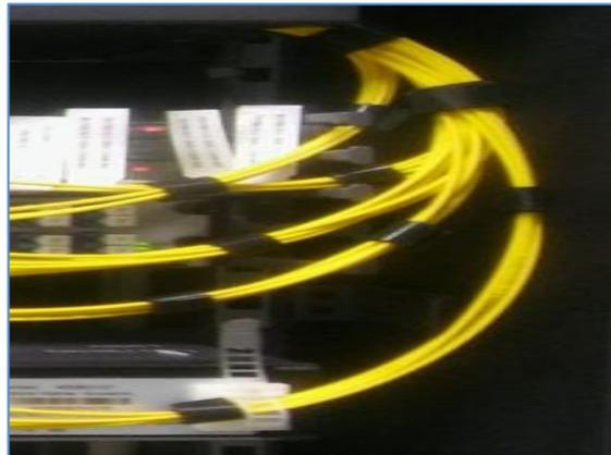
**Figura 3-28.** Ordenamiento de patch cord de fibra para evitando los dobles muy cerrados de la salida y entrada a la bandeja y a las tarjetas del subrack (Fuente: elaboración propia)
