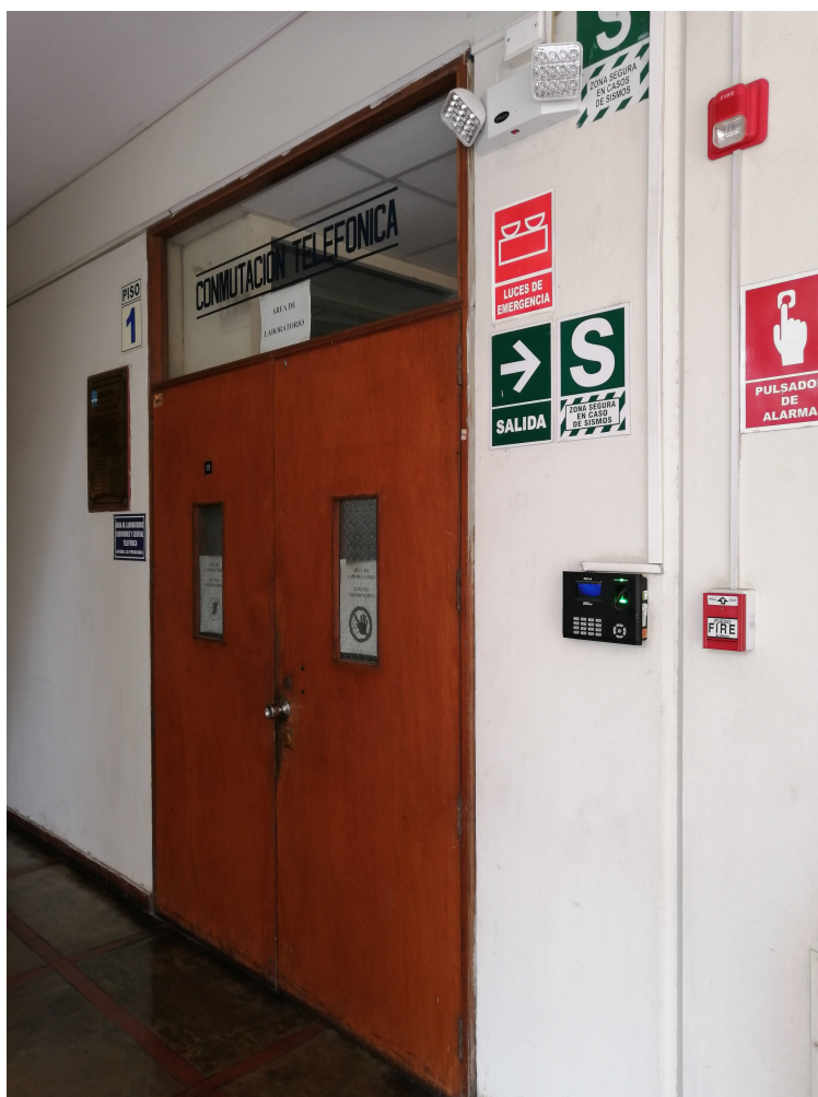
Figura 1.10. Entrada al Centro de Datos Fuente: CLS - DCTT
