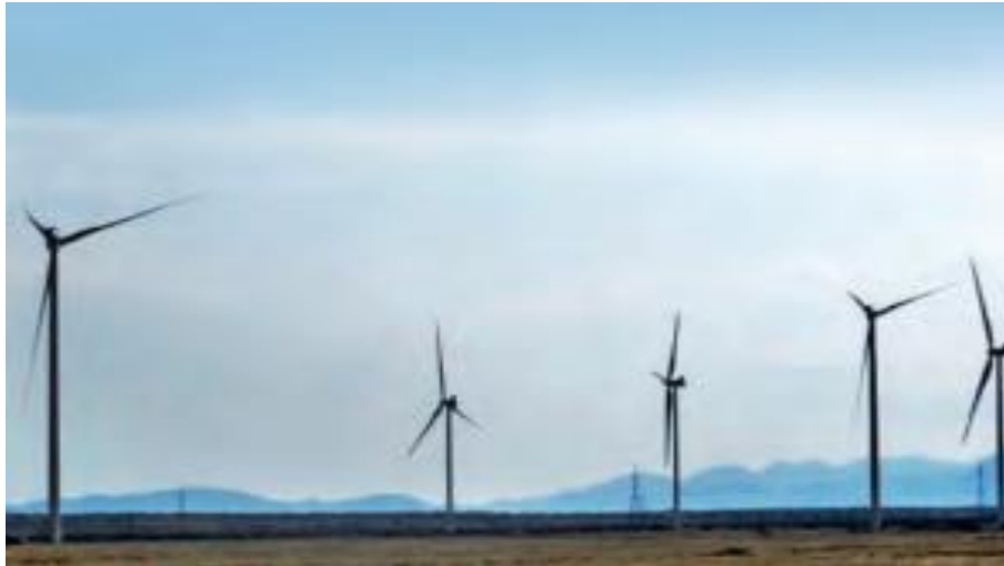
Figura 5. Central Talara (aerogeneradores instalados), Perú. Fuente: Osinergmin (2017)
