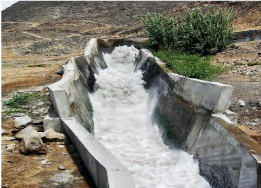
Figura 4. Mini hidráulica Purmacana, Perú, canal de conducción Fuente: (Osinermin, 2017)
