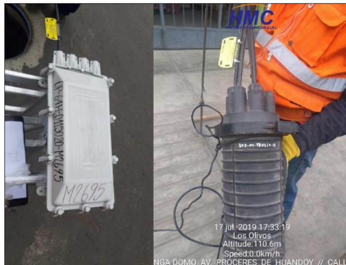
Figura 9. Mufa tipo mondragón (izquierda) y tipo domo (derecha) Fuente: Recuperado de Optical Networks, 2019
