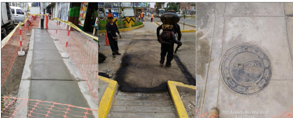
Figura 27. Reposición de veredas y pistas en Av. Marañón Cdr. 07 con Av. Las Palmeras Fuente: Recuperado de Optical Networks, 2019
