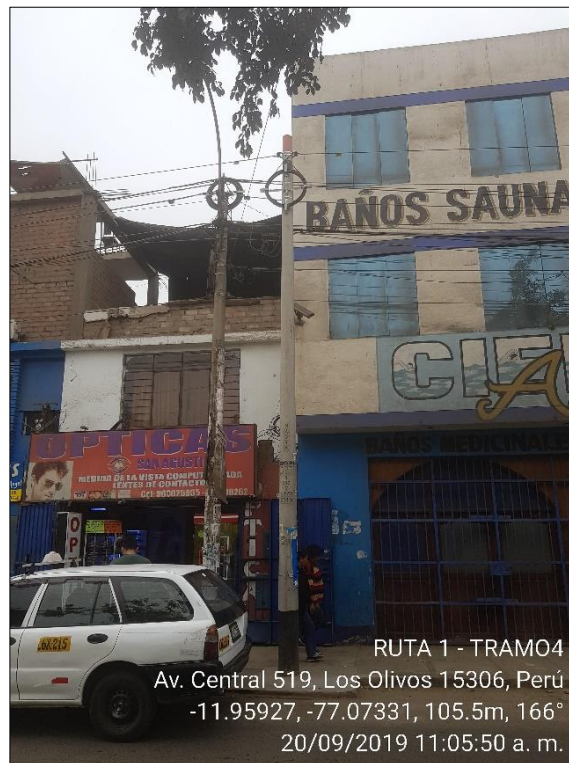
Figura 5. Poste de alumbrado público (izquierda) y poste de Optical Networks (derecha) Fuente: Elaboración propia
