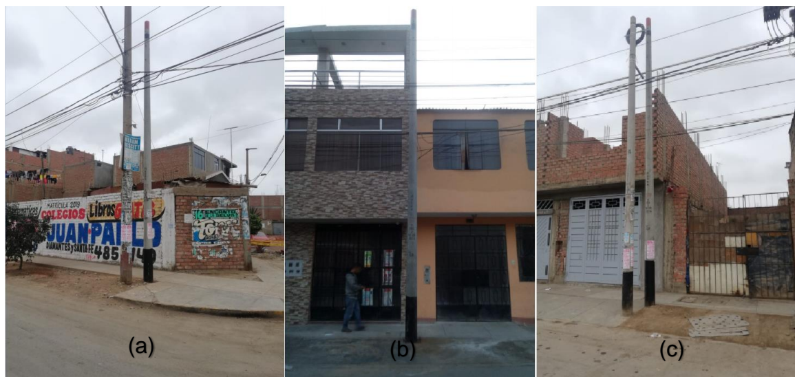
Figura 23. Postes instalados en la Av. Santa Rosa, Asoc. Villa Santa Rosita - S.M.P Fuente: Recuperado de Optical Networks, 2019
