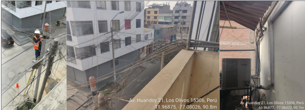
Figura 33. Acceso de fibra óptica a nodo Fuente: Recuperado de Optical Networks, 2020
