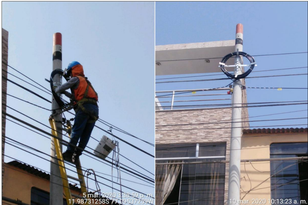
Figura 30. Instalación y adecuación de reserva de fibra óptica en cruceta metálica Fuente: Recuperado de Optical Networks, 2020
