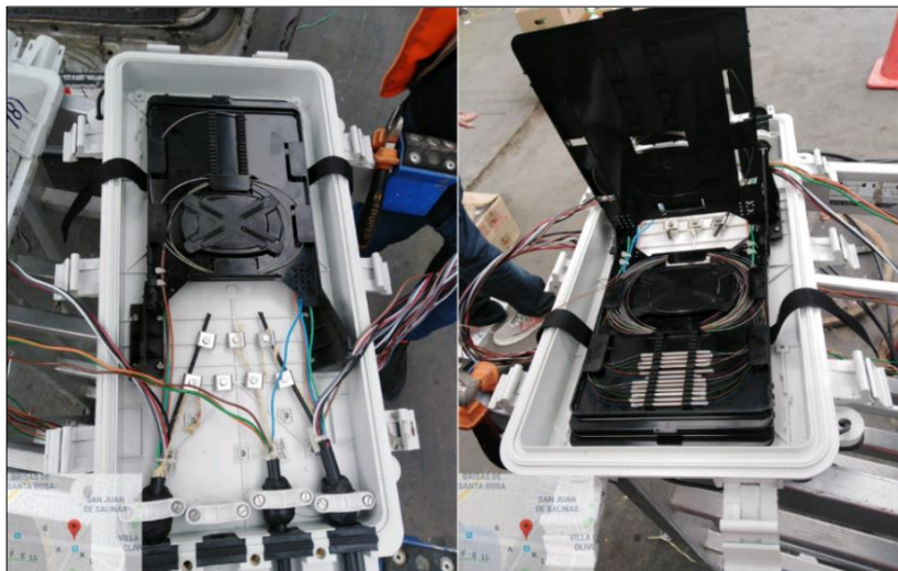
Figura 31. Instalación de manga Mondragón y fusiones en la fibra óptica Fuente: Recuperado de Optical Networks, 2020
