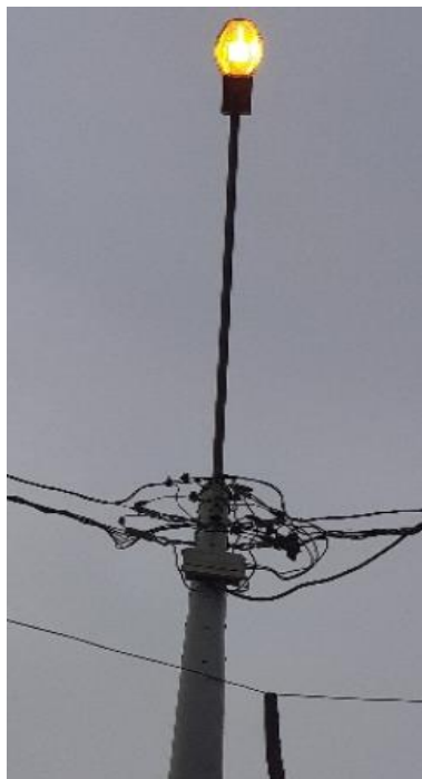
Figura 40. Prueba de encendido de lámparas Fuente: Base de datos de Tecsur S.A.
