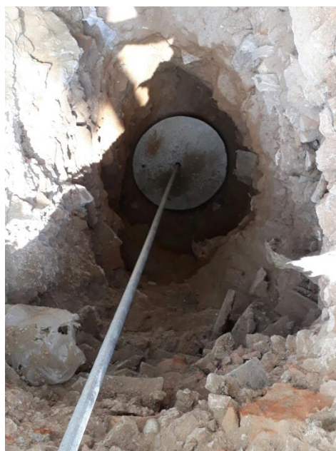
Figura 29. Colocación del bloque de anclaje en el hoyo
