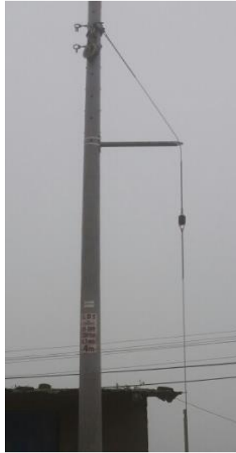
Figura 30. Retenida tipo violín Fuente: Base de datos de Tecsur S.A
