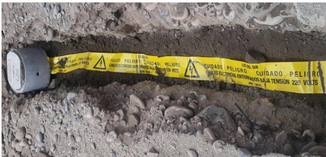
Figura 32. Instalación de pozo a tierra horizontal
