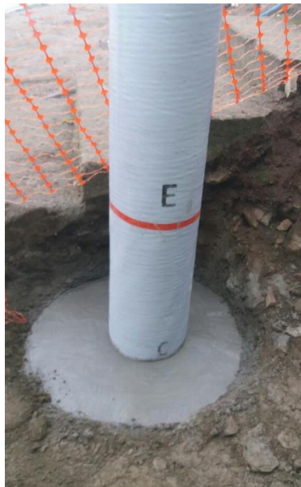
Figura 26. Instalación de poste Fuente: Base de datos de Tecsur S.A.
