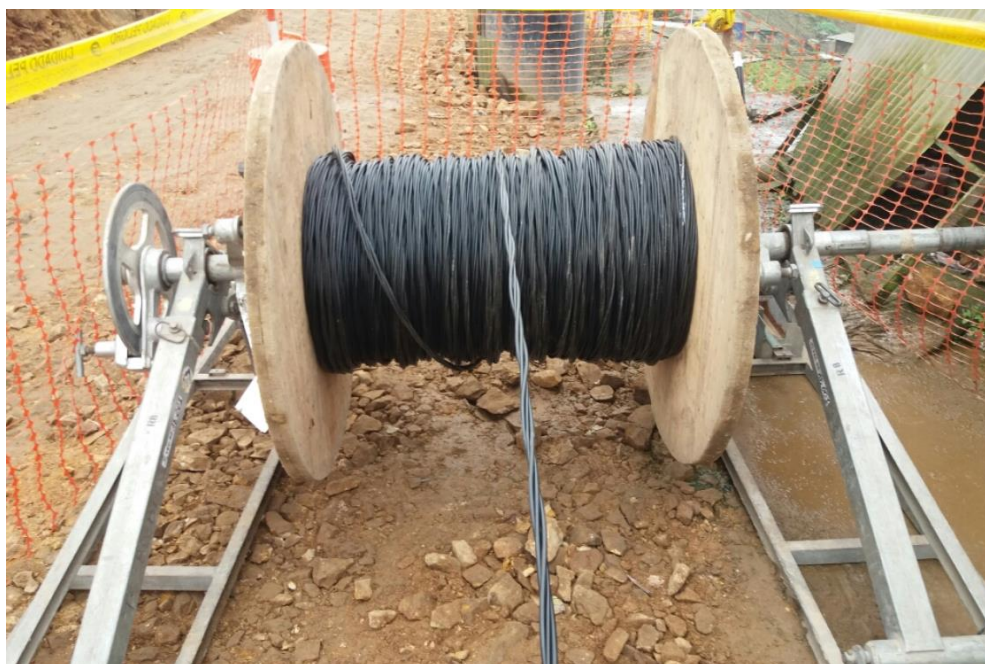
Figura 33. Instalación de porta bobinas
