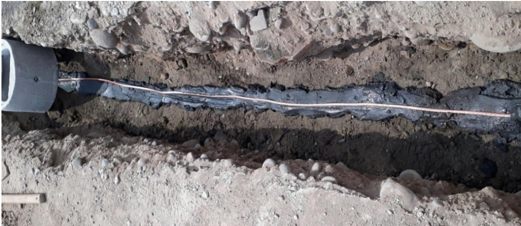
Figura 31. Instalación de pozo a tierra horizontal
