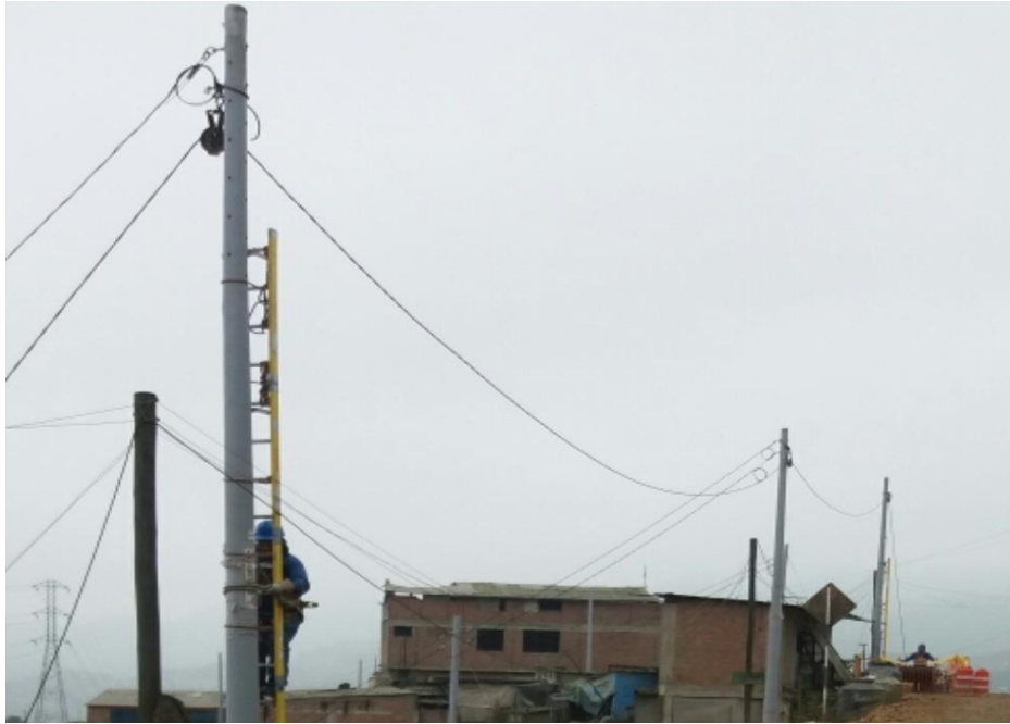
Figura 34. Tendido de conductor Fuente: Base de datos de Tecsur S.A
