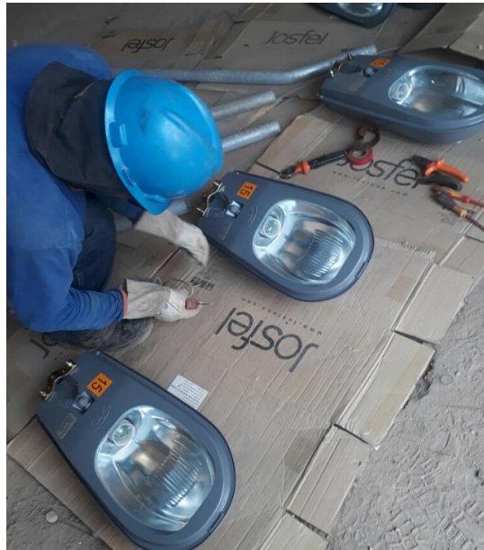
Figura 27. Instalación de luminaria en pastoral
