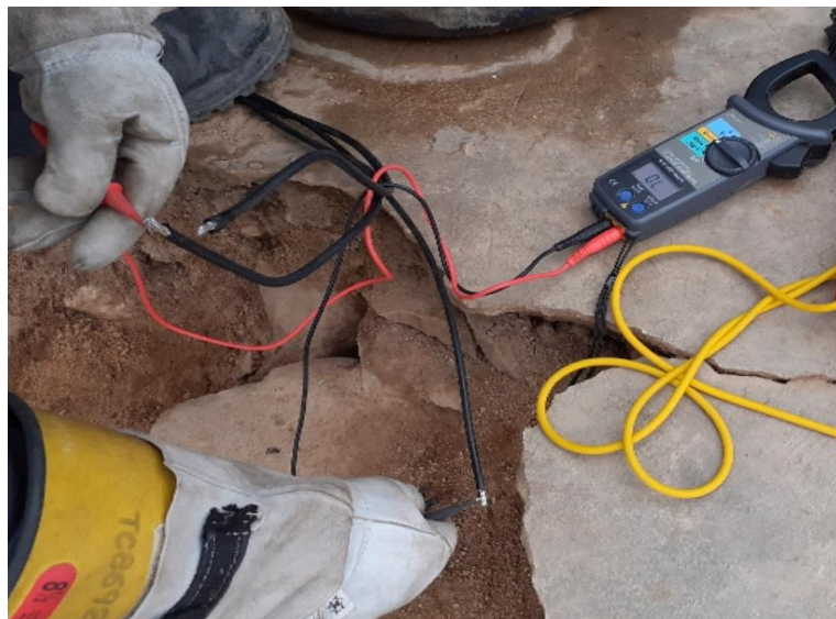
Figura 35. Prueba de continuidad Fuente: Base de datos de Tecsur S.A
