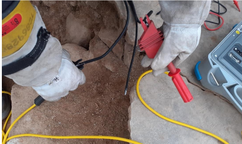
Figura 37. Prueba de aislamiento Fuente: Base de datos de Tecsur S.A.
