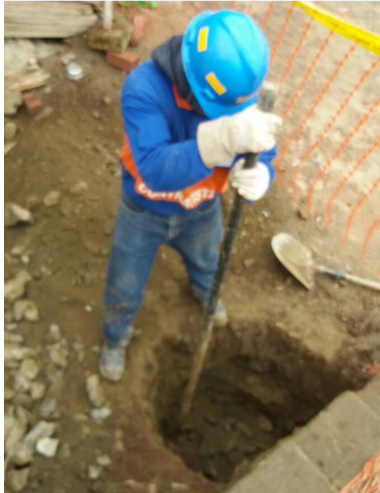
Figura 25. Excavación para poste Fuente: Base de datos de Tecsur S.A.
