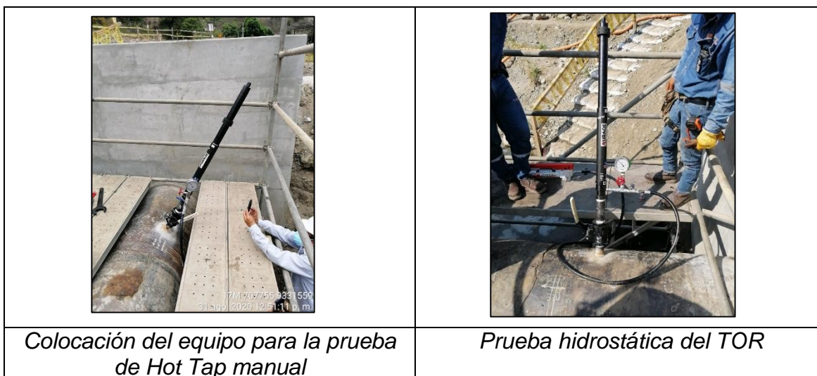
Figura 69: Prueba hidrostática del Tor Fuente: Elaboración propia
