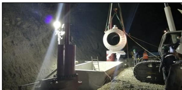
Figura 59: Izaje de la válvula de bloqueo automático Fuente: Elaboración propia
