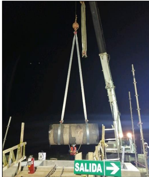
Figura 58: Desmontaje de la tubería cortada Fuente: Elaboración propia
