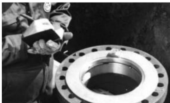
Figura 14: Inspección visual del Fitting (Split Tee) Fuente: Manual del equipo TD WILLIAMSON.
