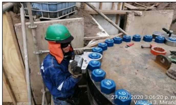
Figura 67: Prueba de hermeticidad de la brida ciega de Split tee Fuente: Elaboración propia
