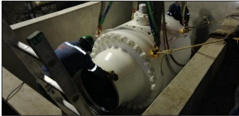
Figura 60: Instalación de la válvula bloqueo automático Fuente: Elaboración propia
