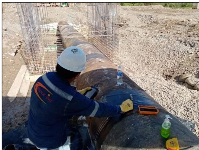
Figura 38: Colocación del gel y medición de espesor con el transductor ultrasónico Fuente: Elaboración Propia
