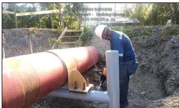
Figura 44: Acabado final de la estructura tipo H Fuente: Elaboración propia
