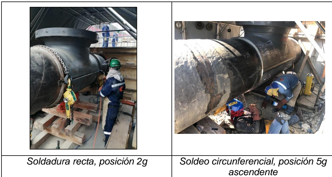
Figura 45: Montaje y armado de los Split tee Fuente: Elaboración propia
