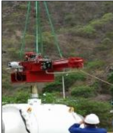
Figura 65: Montaje de la válvula de bloqueo y actuador Fuente: Elaboración propia
