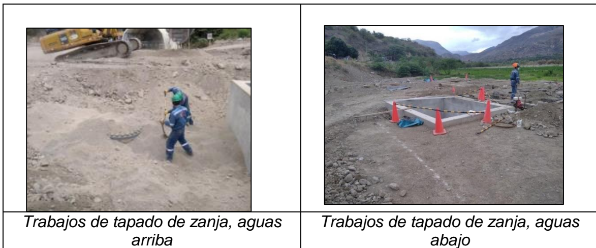
Figura 70: Trabajo de tapado de zanja
