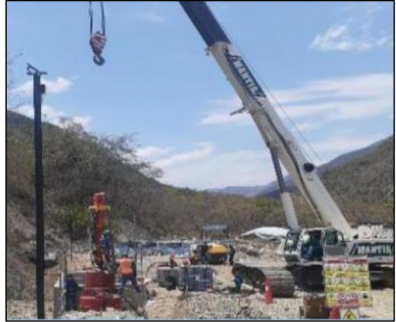
Desmontaje del equipo Hot Tap
