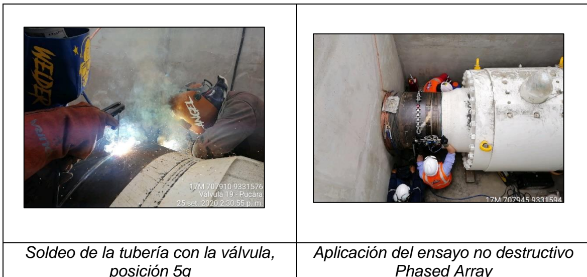
Figura 62: Soldadura y aplicación de END Fuente: Elaboración propia
