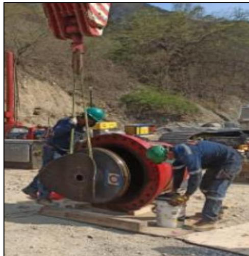
Figura 50: Armado del equipo Hot Tap Fuente: Elaboración propia
