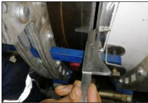
Figura 61: Inspección visual de la junta con galga tipo high low Fuente: Elaboración propia
