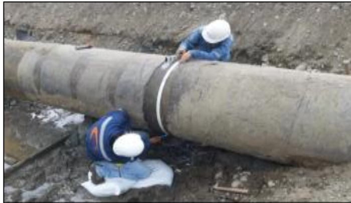
Figura 37: Limpieza del área para tomar la medida de los espesores de pared Fuente: Elaboración Propia
