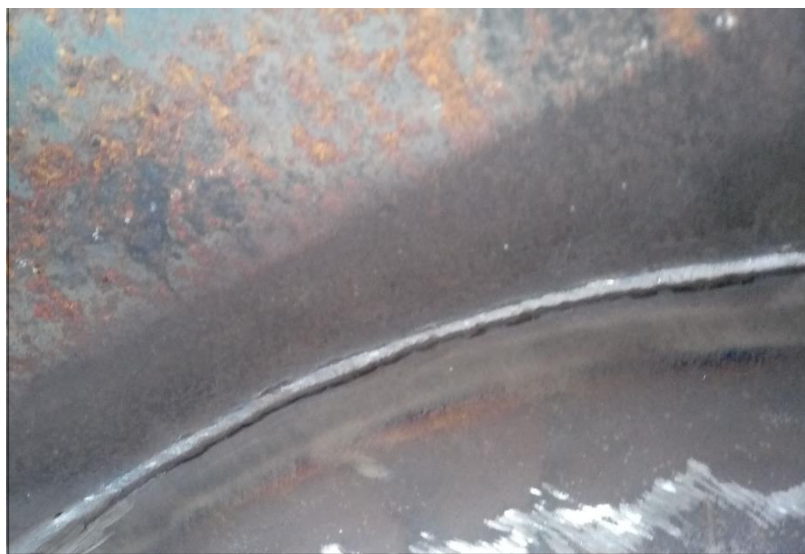
Figura 25. A) Inspección de soldadura interna del tanque
