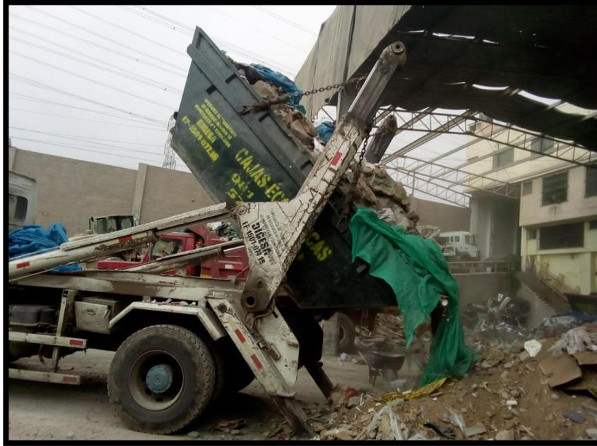
*Figura 20.* Basculación de RCD en el área central de la planta de transferencia y reciclaje (Propia, 2019)
