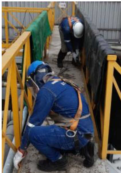
Fabricación e instalación de planchas metálicas para pasadizo de plataforma
