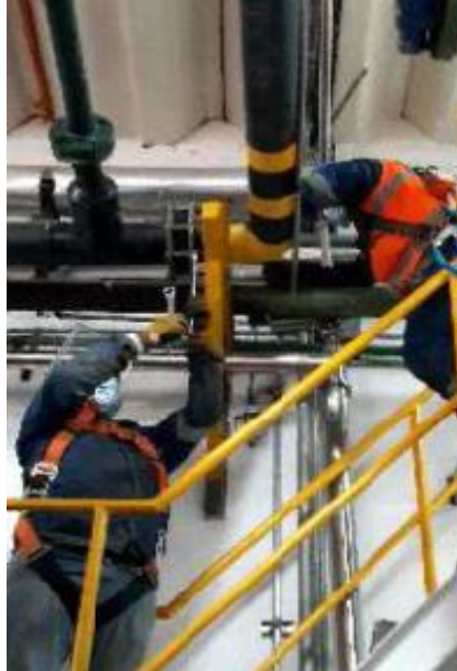
Reparación de fuga tubería HDPE línea de agua
