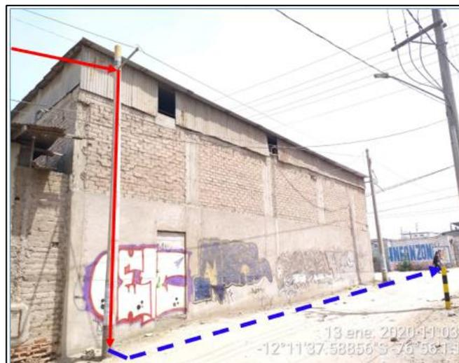
Figura 14.10 Recorrido de la fibra óptica de manera aérea a manera canalizada
