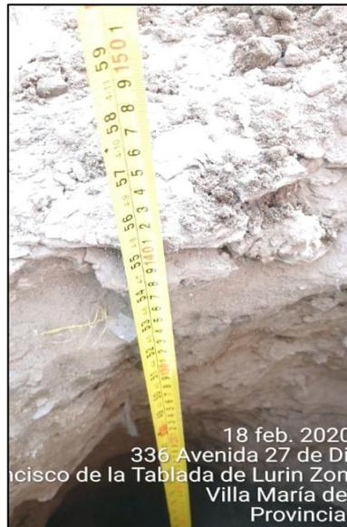
*Figura 14.7 Forado de 1.40m de profundidad en tierra
