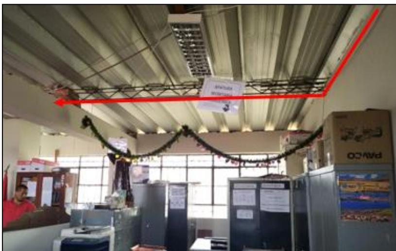
Figura 14.16 Recorrido de fibra óptica sobre viga metálica.
