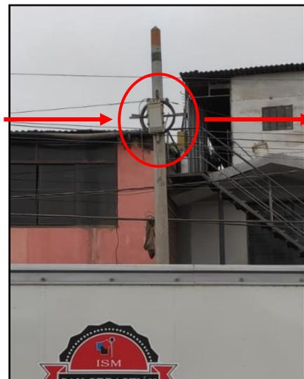
Figura 14.12 Tendido de fibra óptica de 24H llega a poste con manga instalada.
