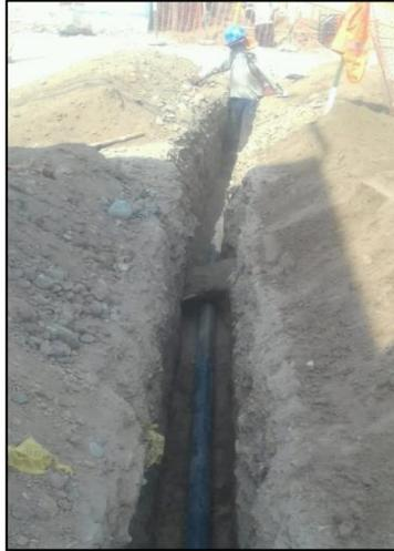
*Figura 14.5 Instalación de tubo de 3 pulgadas*
