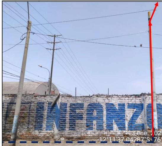
Figura 14.11 Recorrido de la fibra óptica de manera canalizada a manera aérea
