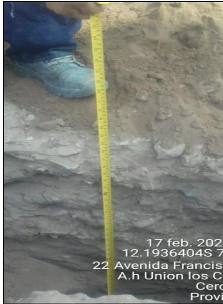
Figura 14.3 Verificación de altura de zanja.
