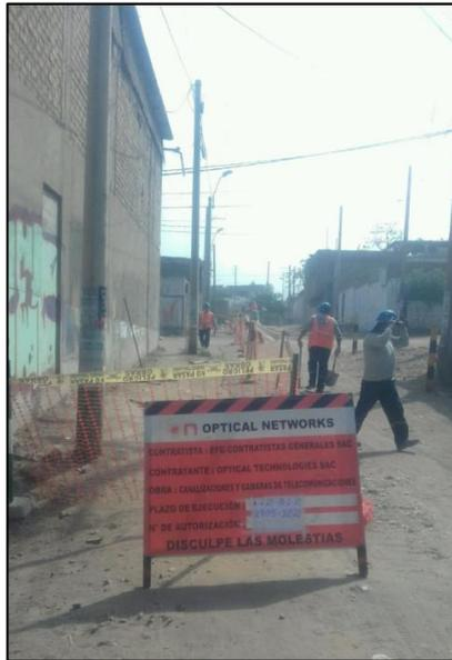
Figura 14.1 Proceso de cercar el área a canalizar
