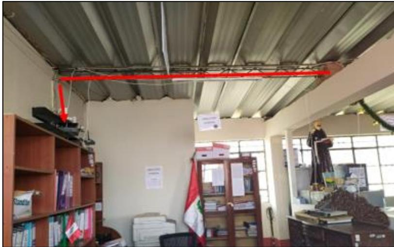
Figura 14.17 Recorrido interno de la fibra óptica
