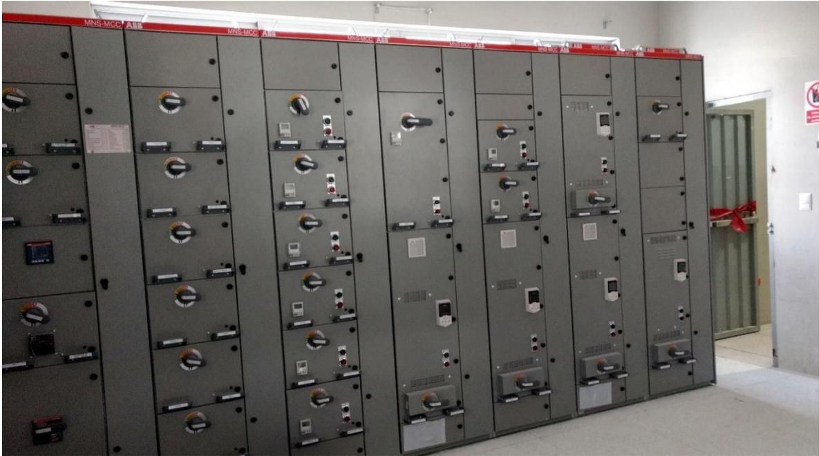
**Figura 53:** CCM instalado.
