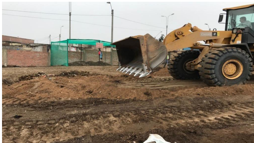
Figura 45. Preparación del terreno Fuente: Propia
