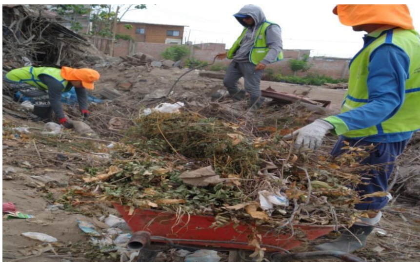
Figura 42. Limpieza y preparación del Área designada donde se implementó la Planta de Valorización de RSO de Villa el Salvador Fuente: Propia
