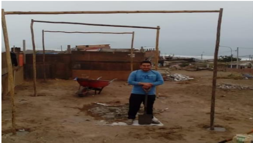
Figura 44. Construcción de unidades productivas que conforman la Planta de Valorización de RSO de Villa el Salvador Fuente: Propia
