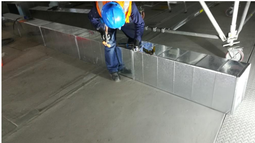
Armado de ductos mediante correderas.
