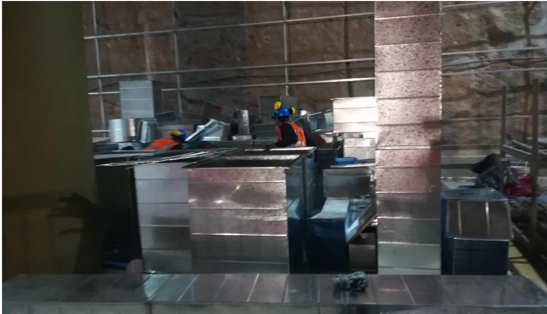
Acopio de ductos
