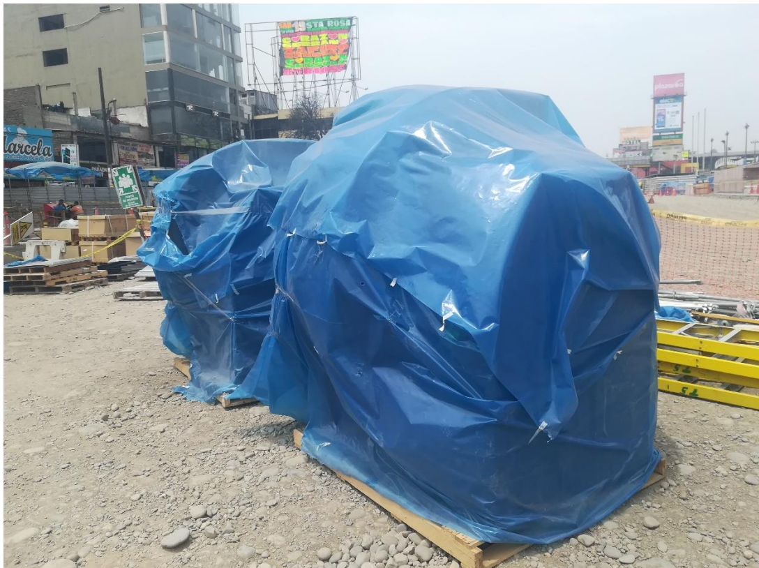
Llegada a obra de los ventiladores VE-SER y VI-SER
