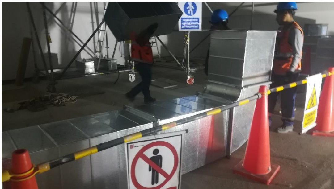
Pre ensamblado de ductos in situ
