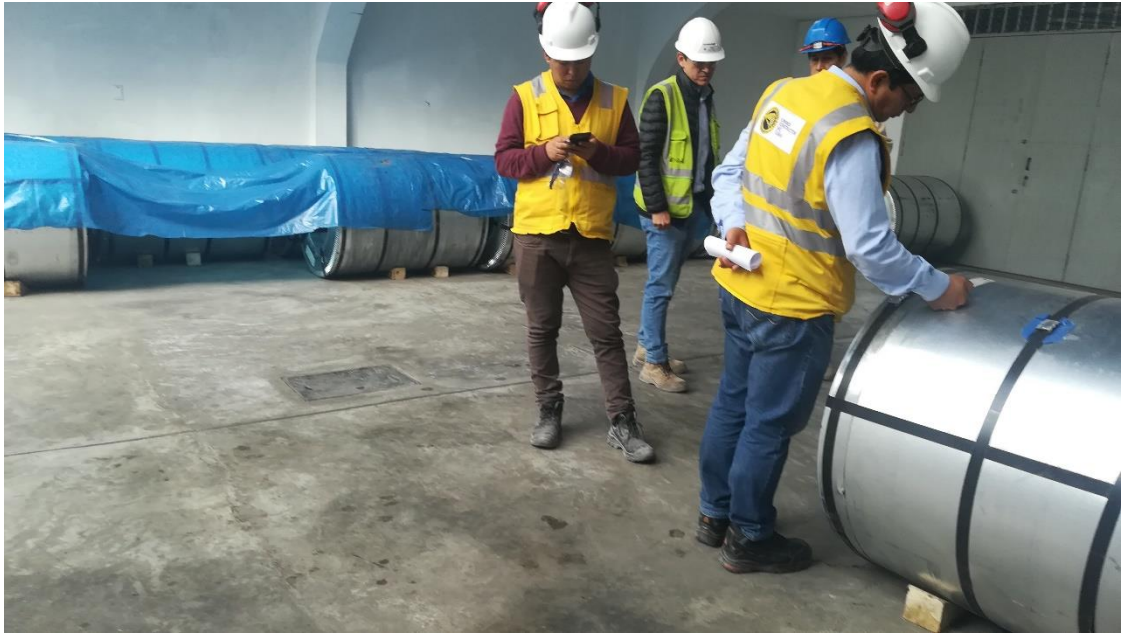
Inspección por parte del consorcio del material para la fabricación de ductos
