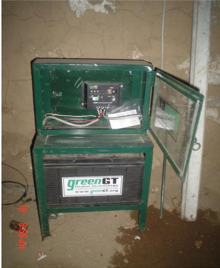
**Sistema Metálico Porta Batería - inferior**
