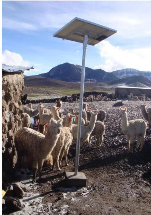
Vista general de un panel fotovoltaico instalado sobre un rack metálico y soportado por un tubo metálico de F°G° sobre una base de cemento ciclópeo.
