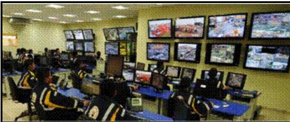
Figura 2. Centro de control de operaciones. Fuente: http://munisurco.gob.pe/gsc/contenido/seguridad_ciudadana/contenido_serenazgo/cco.html .
