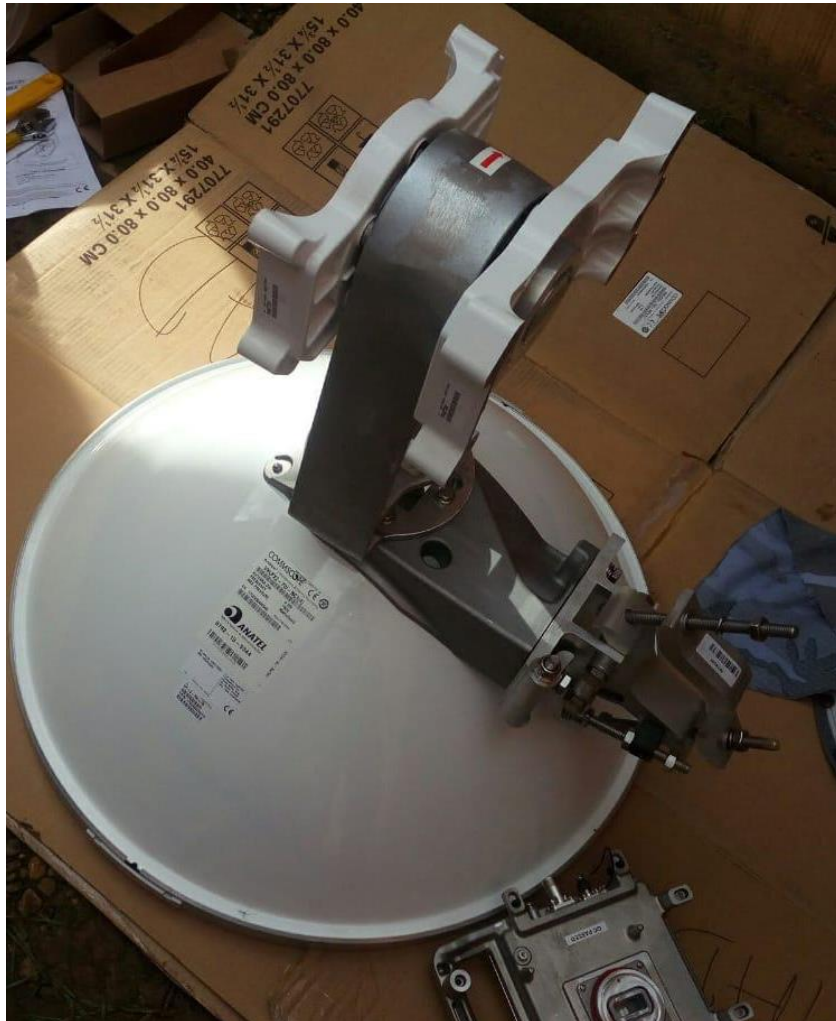
Figura 24 Instalación de OMT a la Antena
