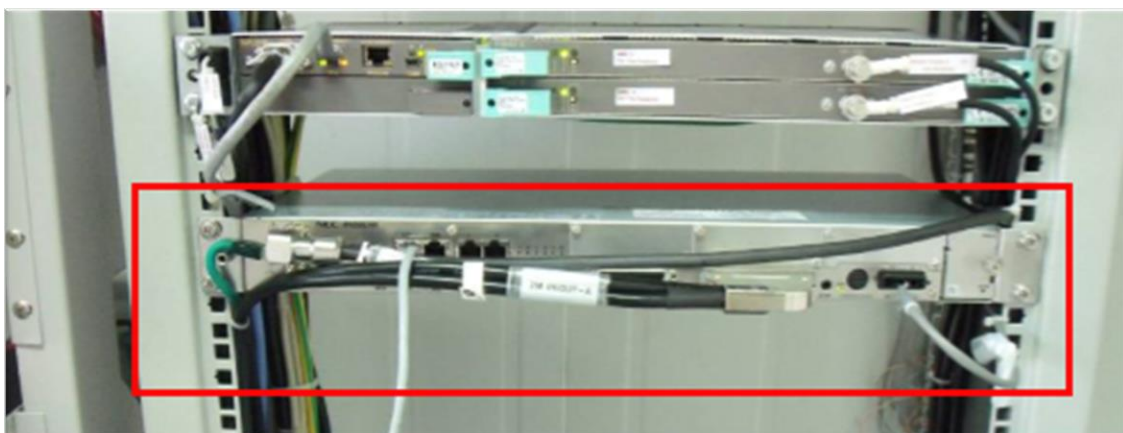
Figura 31 Instalación del equipo NEC iPasolink400A
