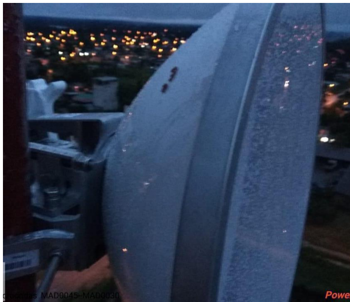
Figura 27 Instalación de equipos a torre.
