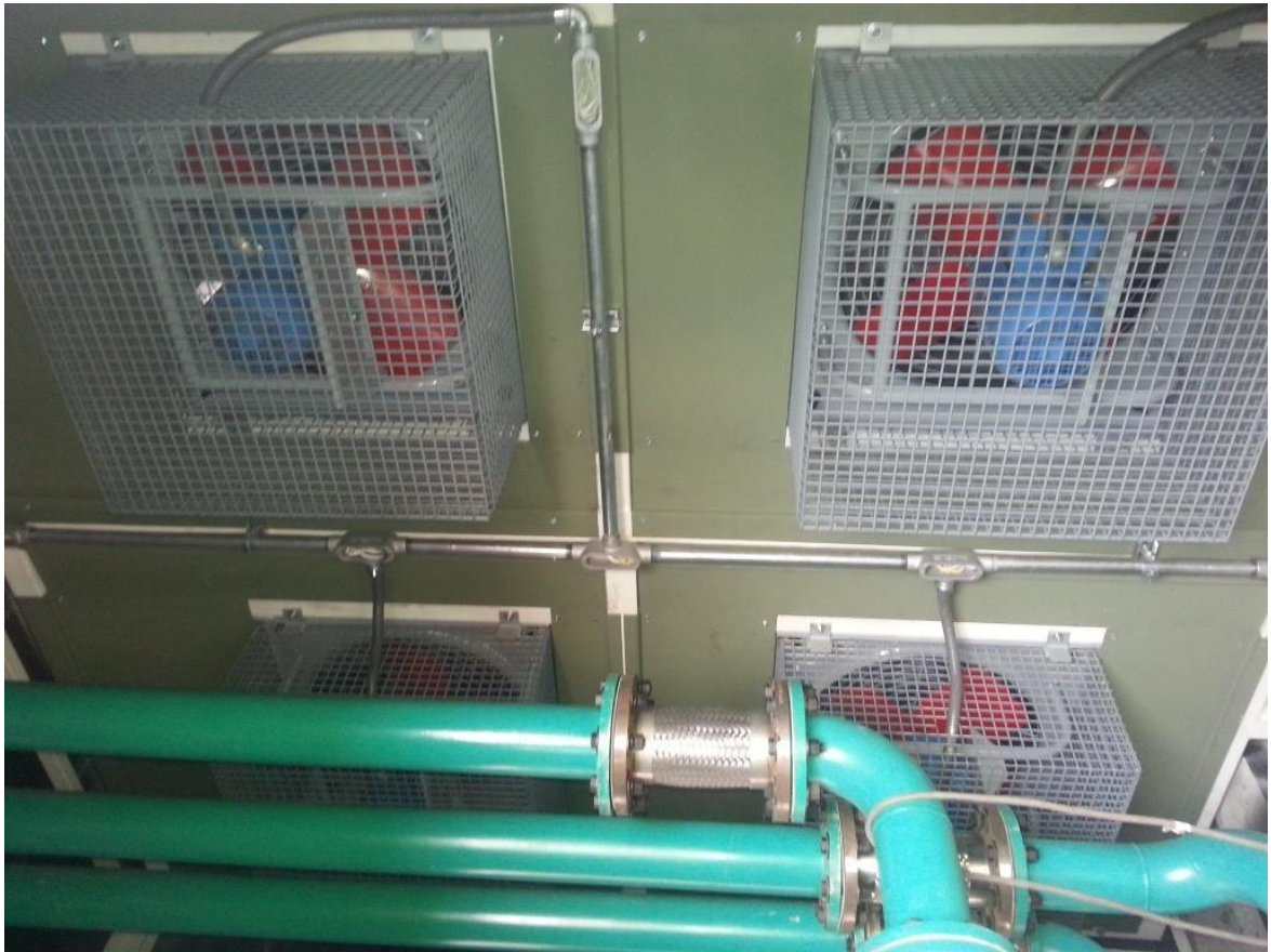
Figura N°21 – Montaje de ventiladores axiales
