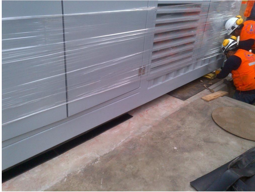
Figura N° 40 – instalación de neoprene
