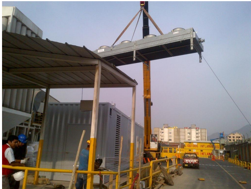
Figura N° 41 – Izaje de radiador remoto
