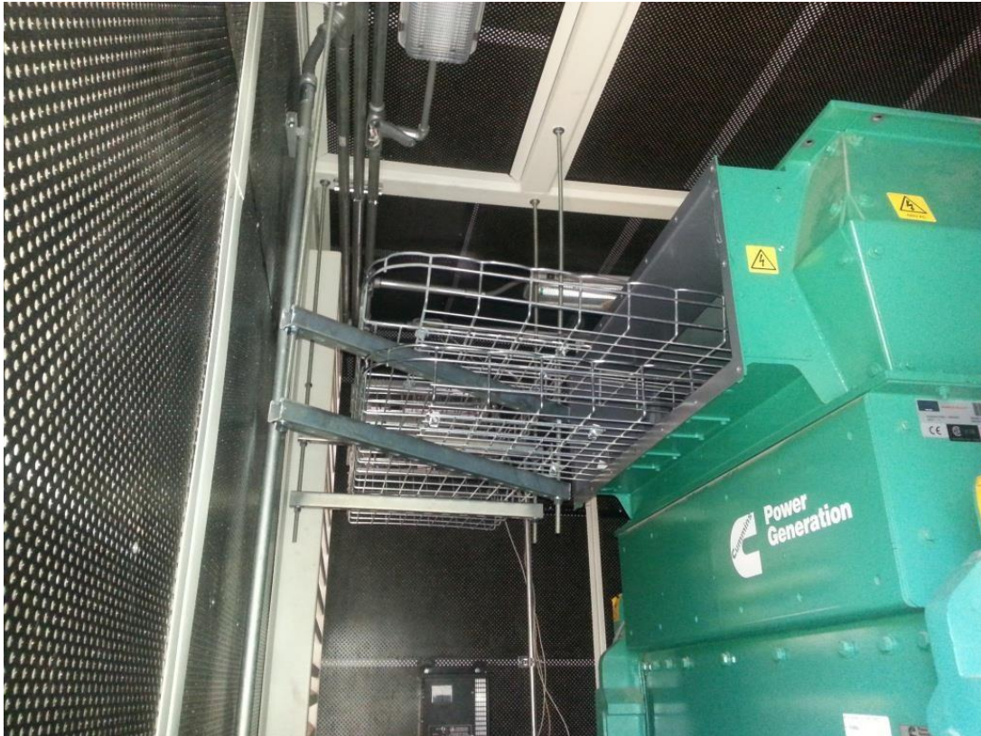
Figura N°26 – Montaje de la bandeja eléctrica del alternador al ITM general
