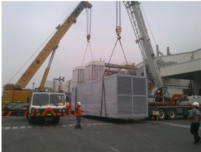
Figura N° 38 – descarga de contenedor
