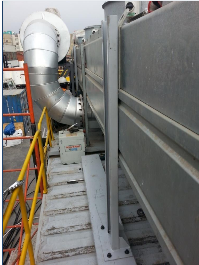
Figura N° 18 – Vigas de refuerzo para Radiador Imagen propia
