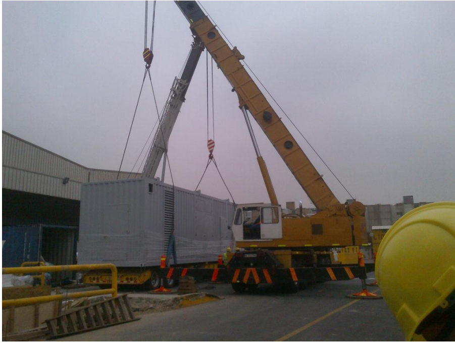
Figura N° 37 – Izaje de contenedor
