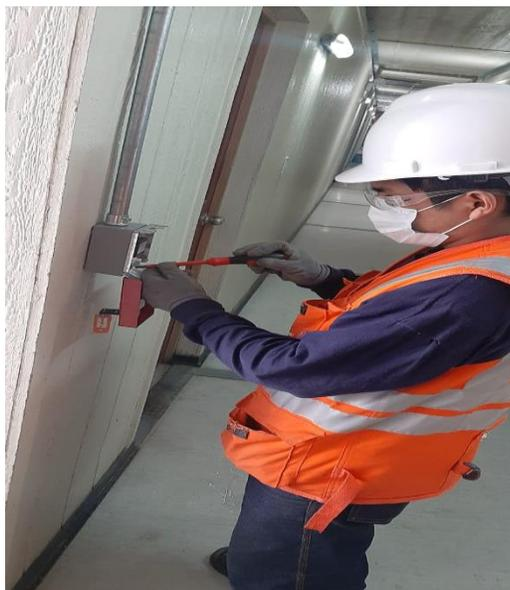
**Figura 47.** Instalación de estación manual
