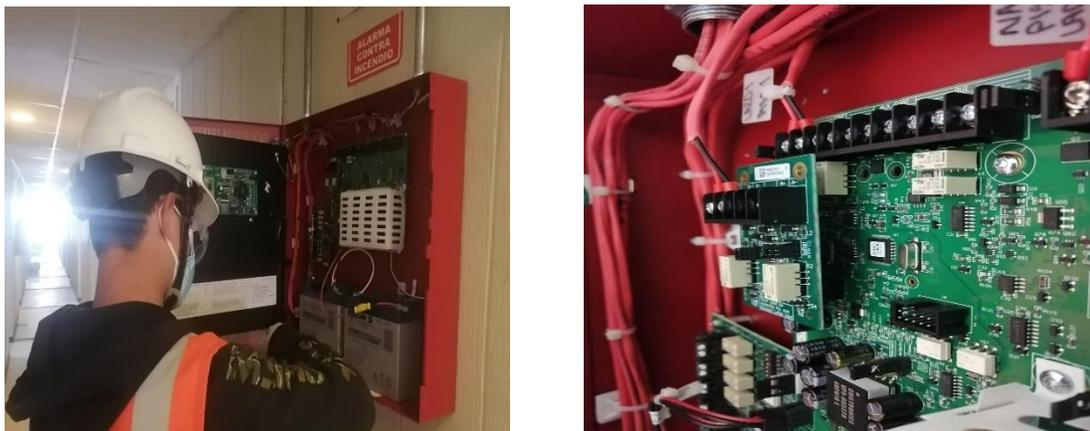
**Figura 70.** Panel de alarmas 4007ES conexiones
