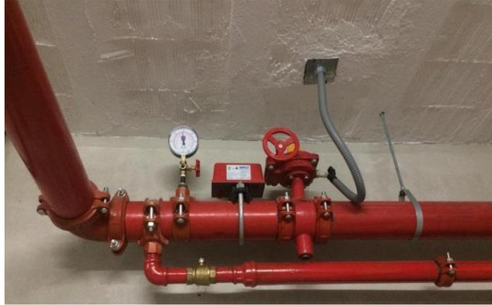
**Figura 50.** Válvula y sensor de flujo
