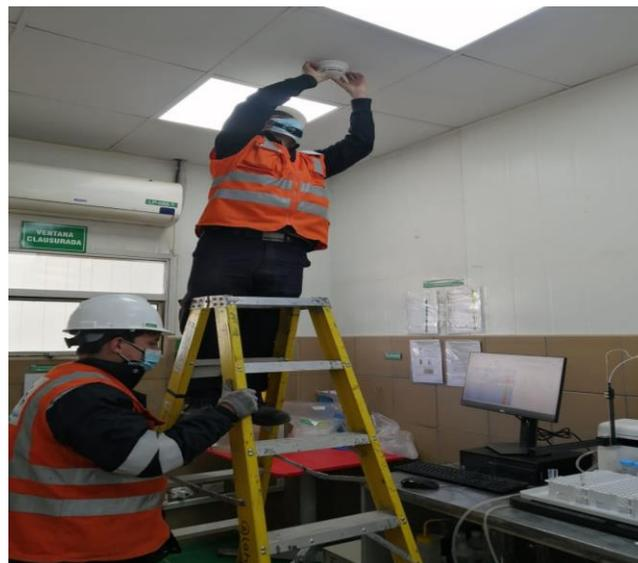
**Figura 45.** Instalación de detectores
