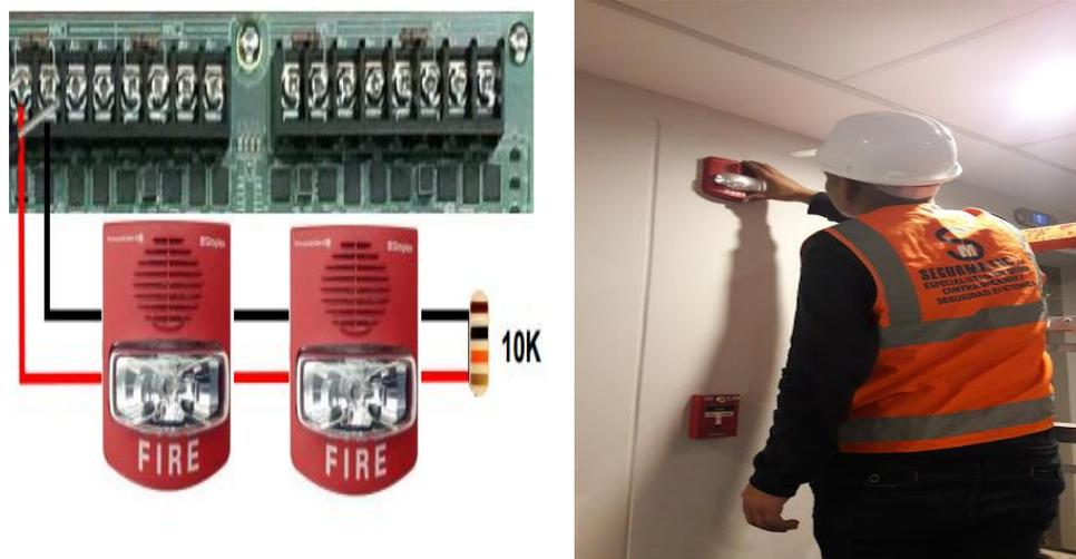
**Figura 48.** Conexión e instalación de sirenas estroboscópicas
