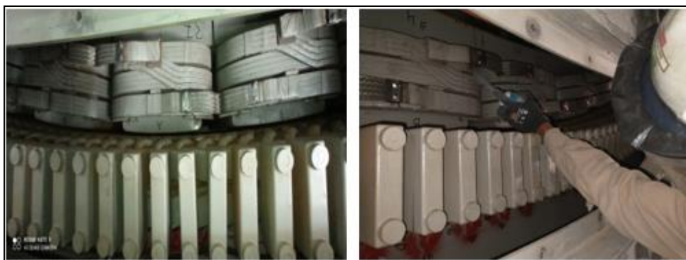
Figura 14: Mantenimiento en las conexiones del polo al molino ML 601. Fuente: Elaboración propia
