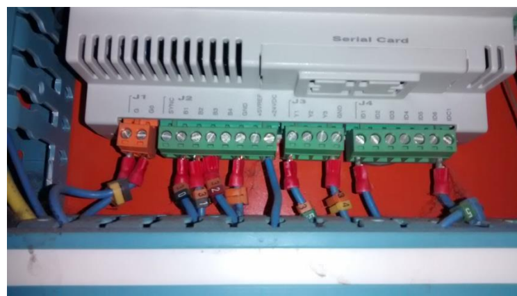
Figura 22. Conexiones inferiores del controlador PCOxs
