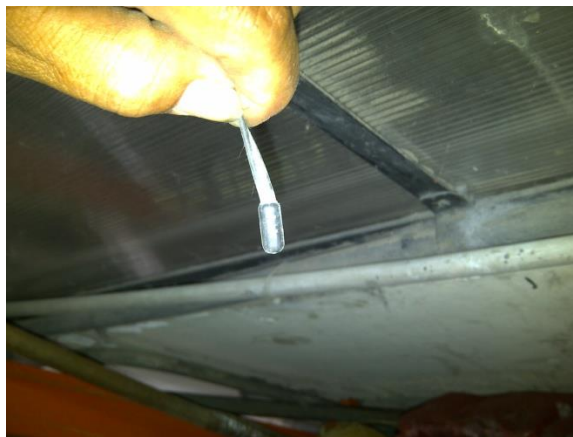
Figura 11. Ubicación de Sensor de temperatura 103AT-11
