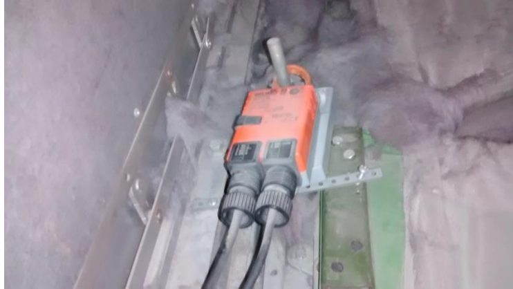
Figura 10. Vista frontal del actuador BELIMO
