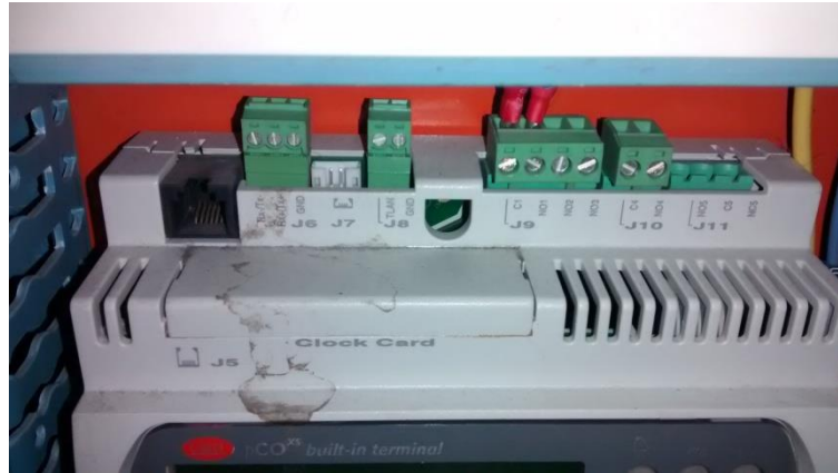
Figura 23. Conexiones superiores del controlador PCOxs
