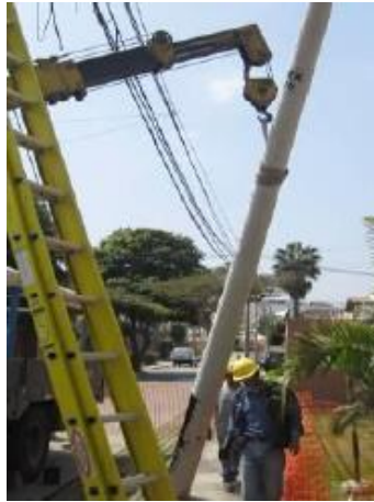
Figura 33. Finalizando colocación de poste para su posterior cimentación.
