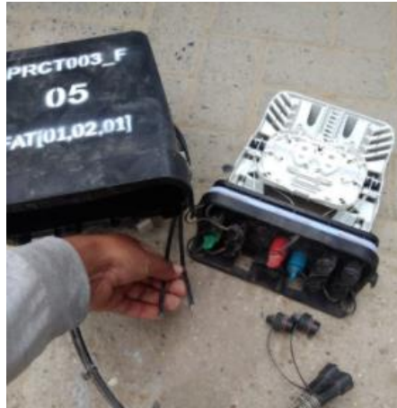
Figura 20. Caja de terminación Óptica
