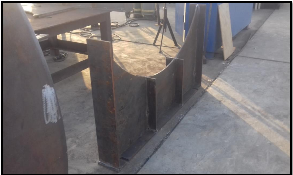
Imagen A.7.8. Armado de silletas.
