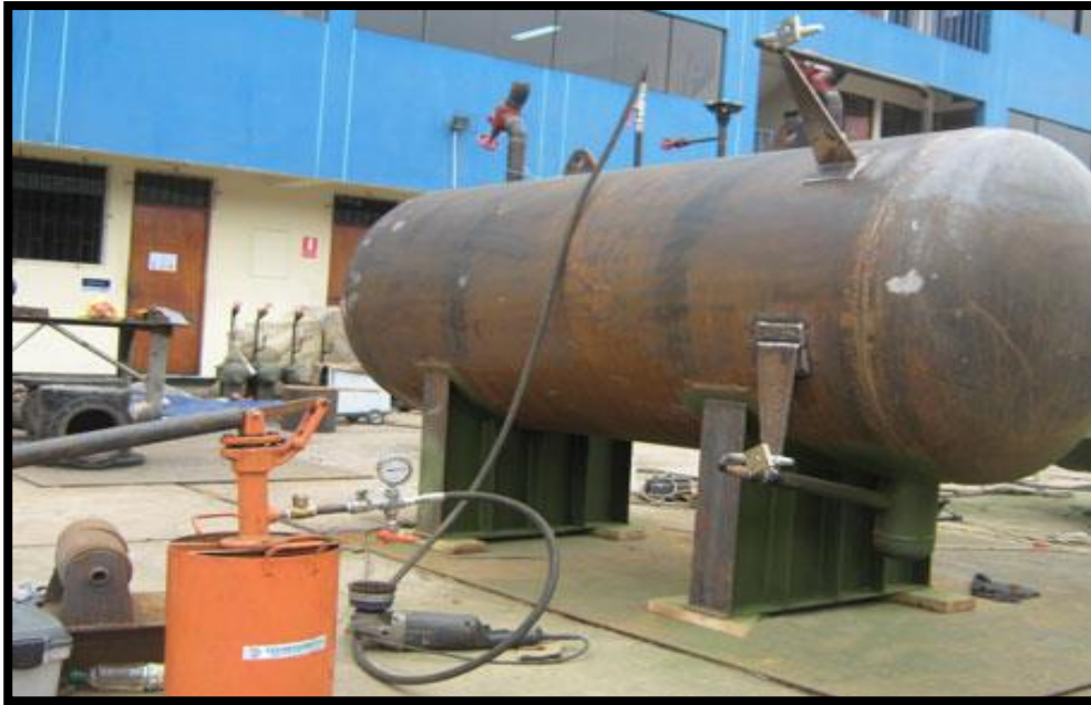
Imagen 3. Prueba Hidrostática a Tanque a Presión.
