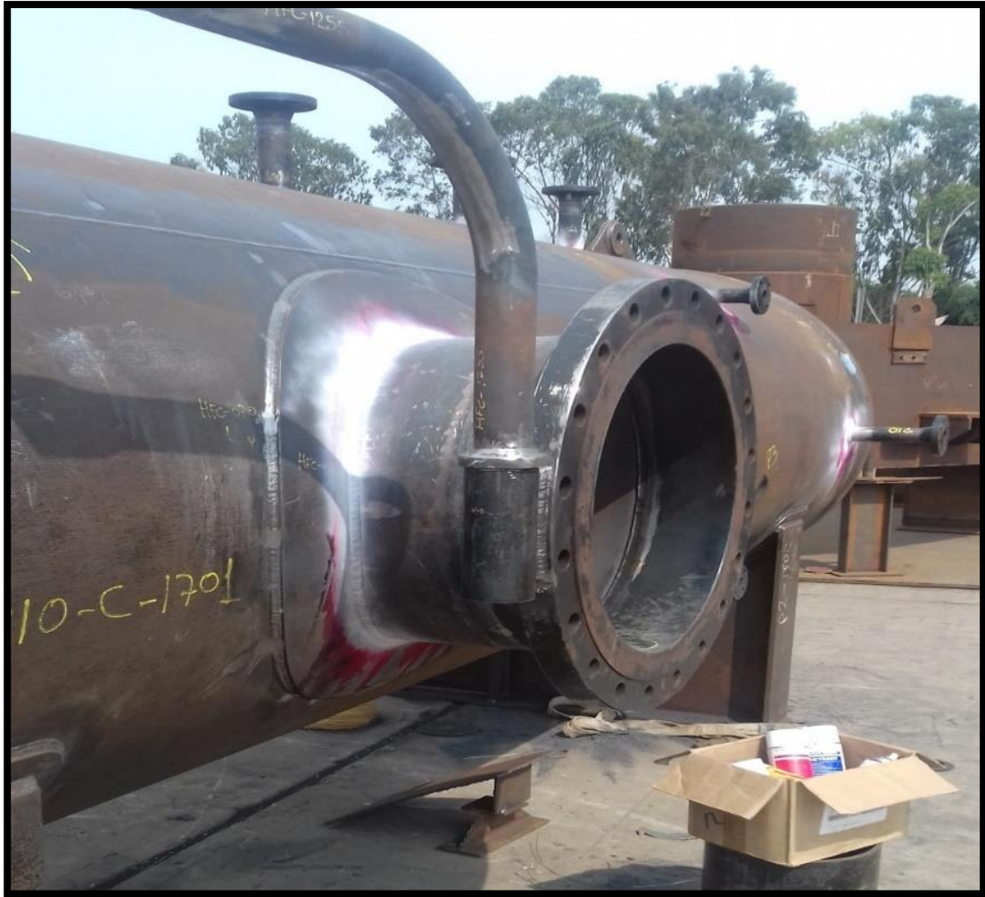
Imagen A.7.9. Soldado de Manhole e Inspección por tintes penetrantes a boquillas.
