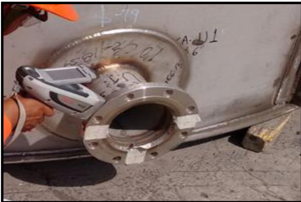
Imagen 4. Realización de PMI a boquilla de tanque API 650.
