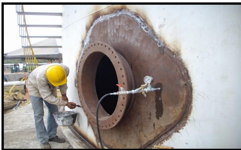
Trabajo de Prueba Neumática realizado a la boquilla de un tanque API 650.
