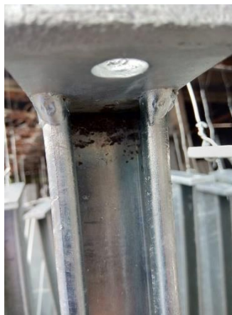
Figura 19. Zonas sin recubrimiento.
