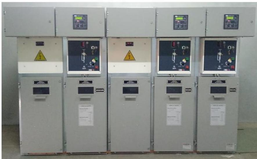
Figura 40. Celdas de MT instaladas.
