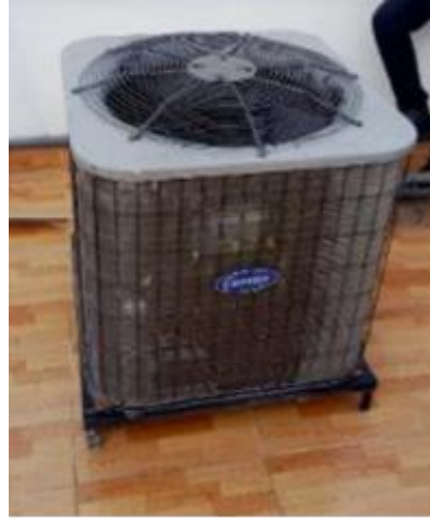
Unidad condensadora
