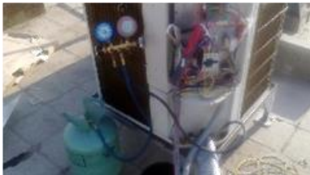
Figura 38. Recarga de gas refrigerante R410A
