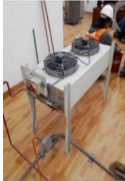
Unidad Condensadora
