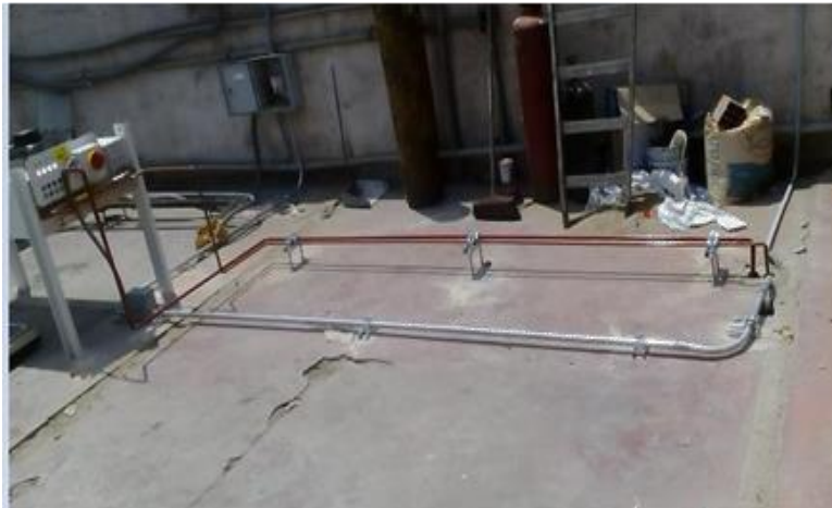
Figura 35. Instalación de tubería de cobre en el sistema de aire acondicionado de precisión
