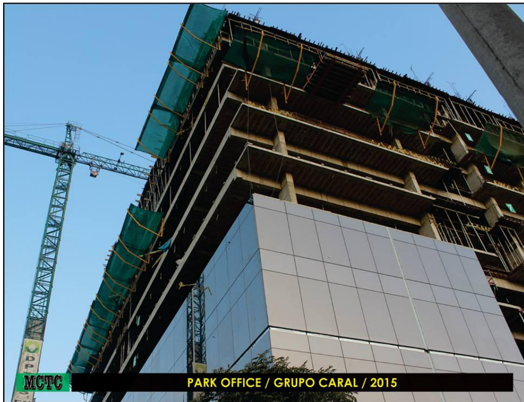
Figura 18 Fotografía de Mallas de raschel instaladas en el proyecto del Grupo Caral (Mayo, 2015).
