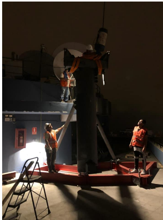
Figura 20: Izaje pedestal antena 6.1m
