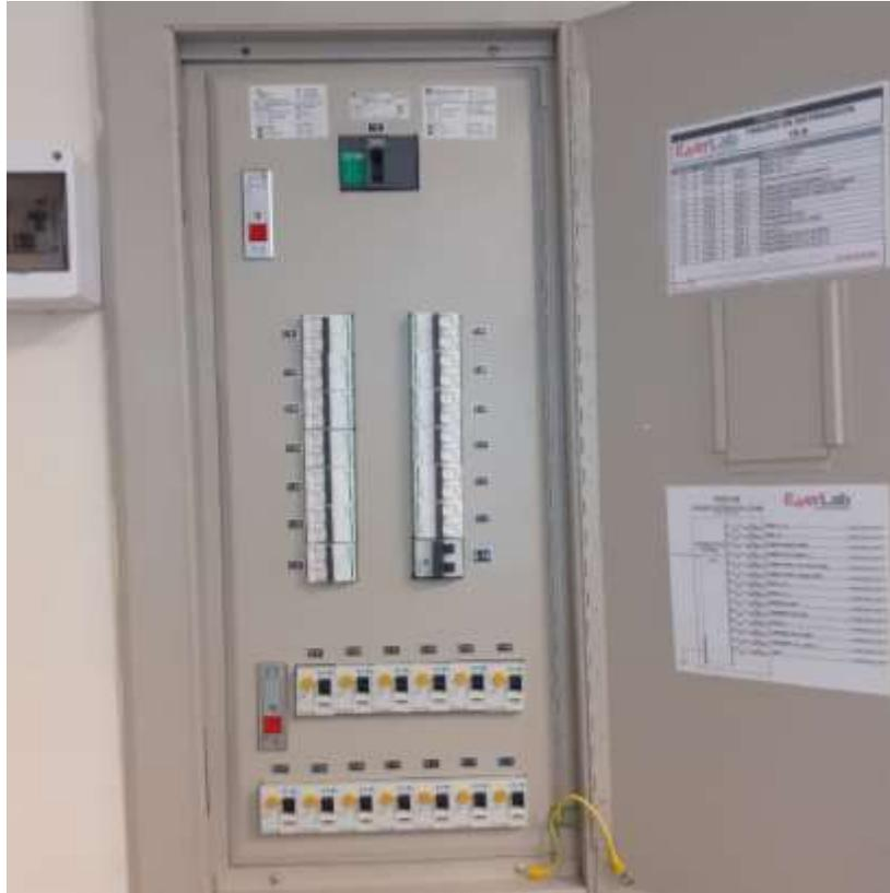
*Ilustración 2.* Ejemplo de tablero de distribución
