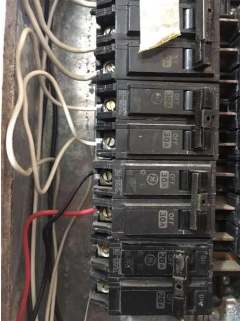
*Ilustración 14. Mal dimensionamiento de los conductores*
