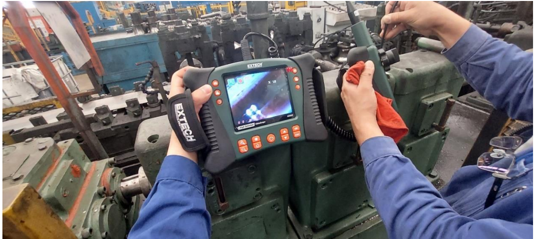
Figura 3.33 Inspección a caja reductora con videoscopio EXTECH HDV600
