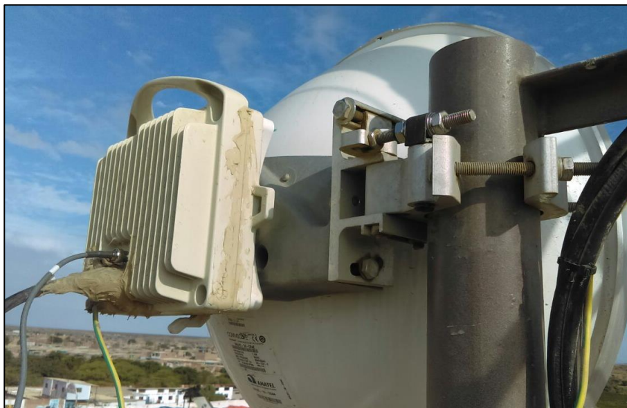
Figura 46. Instalación de equipamiento externo lado cliente Fuente: Elaboración propia
