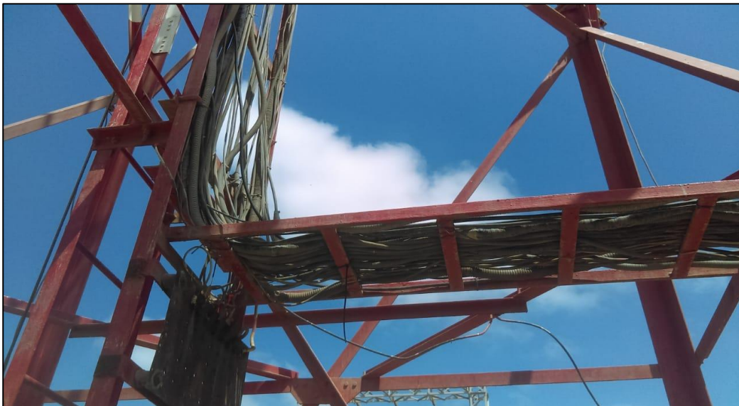
Figura 40. Escalerilla de torre lado nodo
