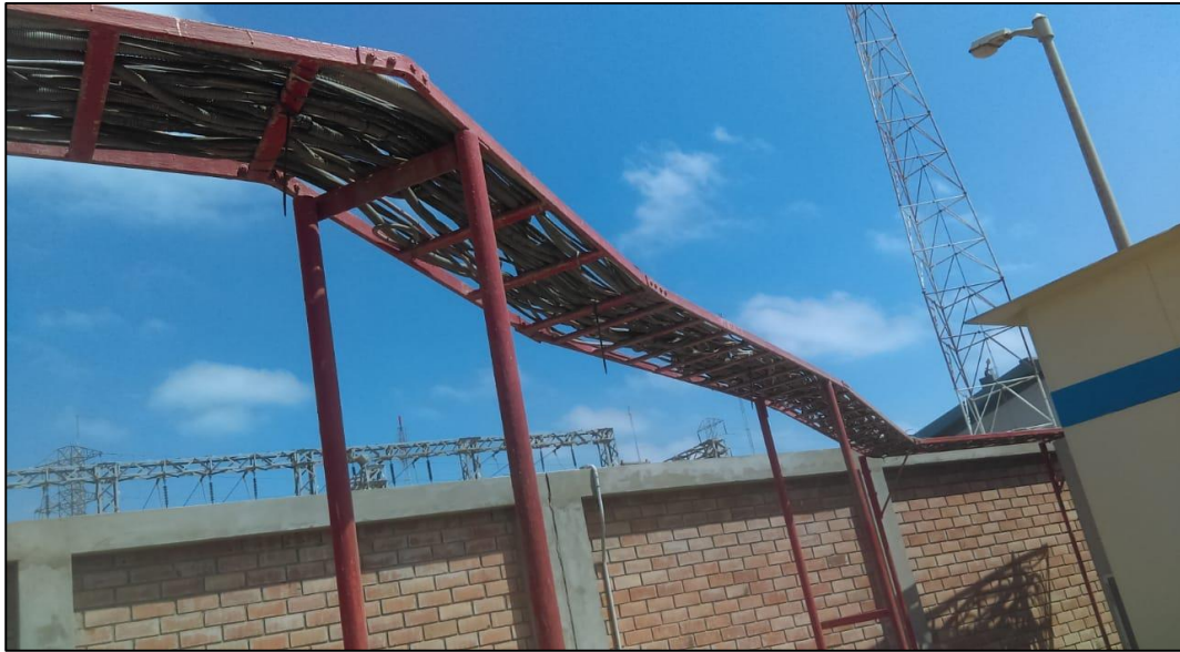
Figura 41. Ingreso de escalerilla a caseta Fuente: Elaboración propia
