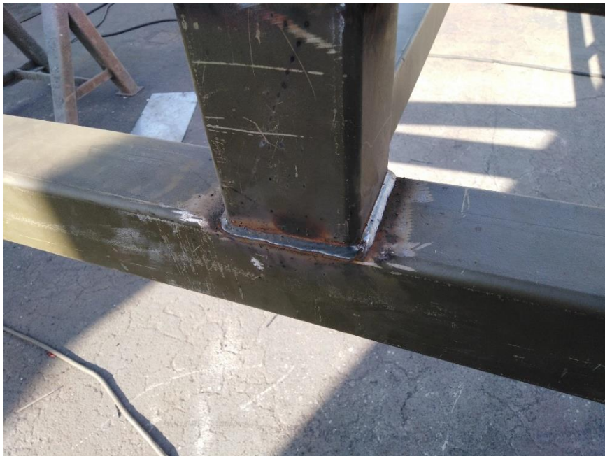
Figura 20. Inspección visual de soldadura
