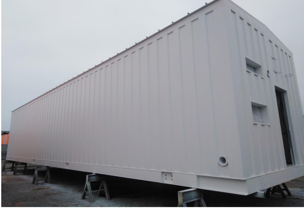
Figura 18. Pintado exterior de sala eléctrica
