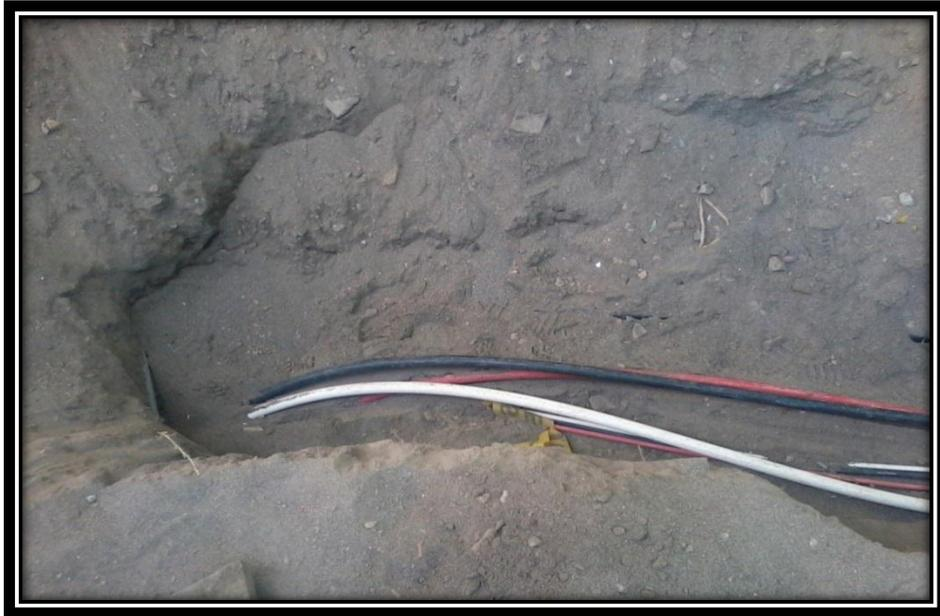
**FIGURA 2.1:** Cable conductor de 3-1x70 N2XSY(Fuente propia)
