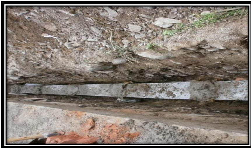
**FIGURA 3.7** : Ductos de 4 vías. (Fuente propia)
