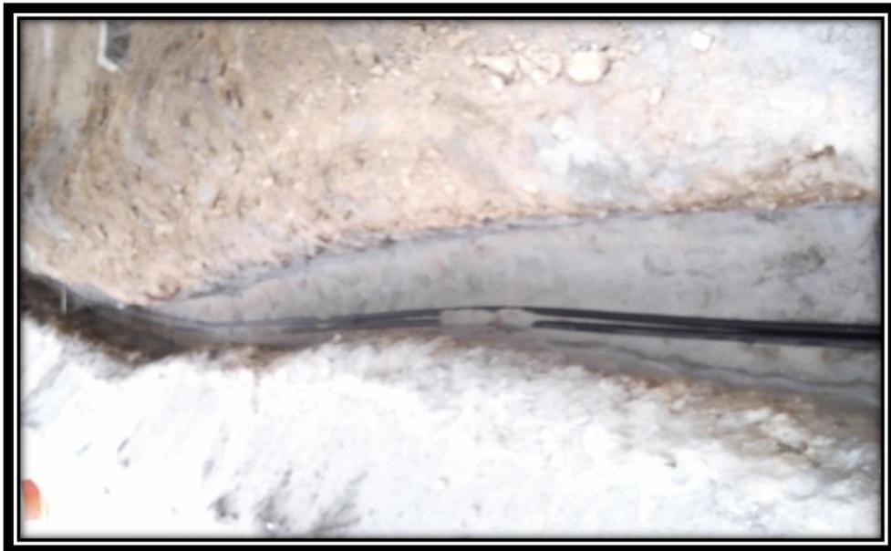
**FIGURA 2.2:** : Cable conductor de 3-1x70 NYY(Fuente propia)
