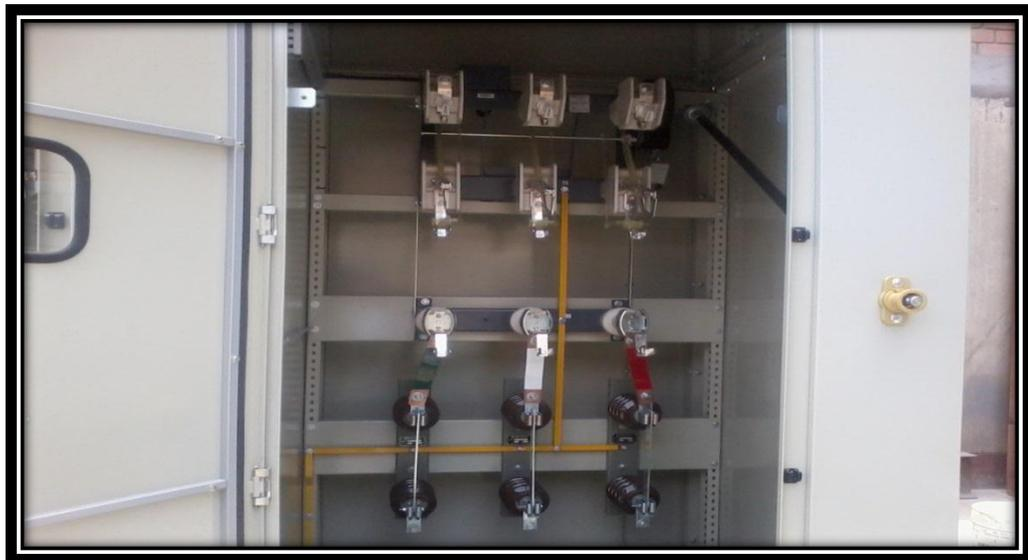
**FIGURA 3.2:** Interior de celda de media tensión (Fuente propia)
