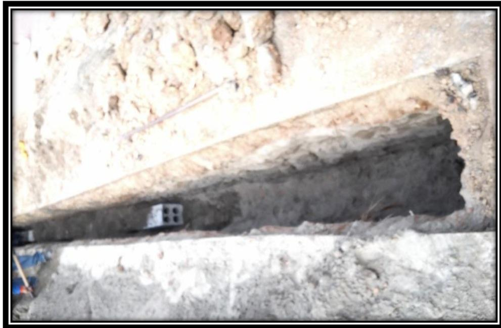
**FIGURA 3.4** : Excavación de la zanja de media tensión.
