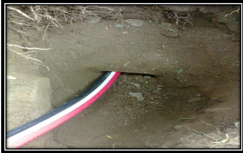
**FIGURA 3.8** : Instalación del cable en ducto.
