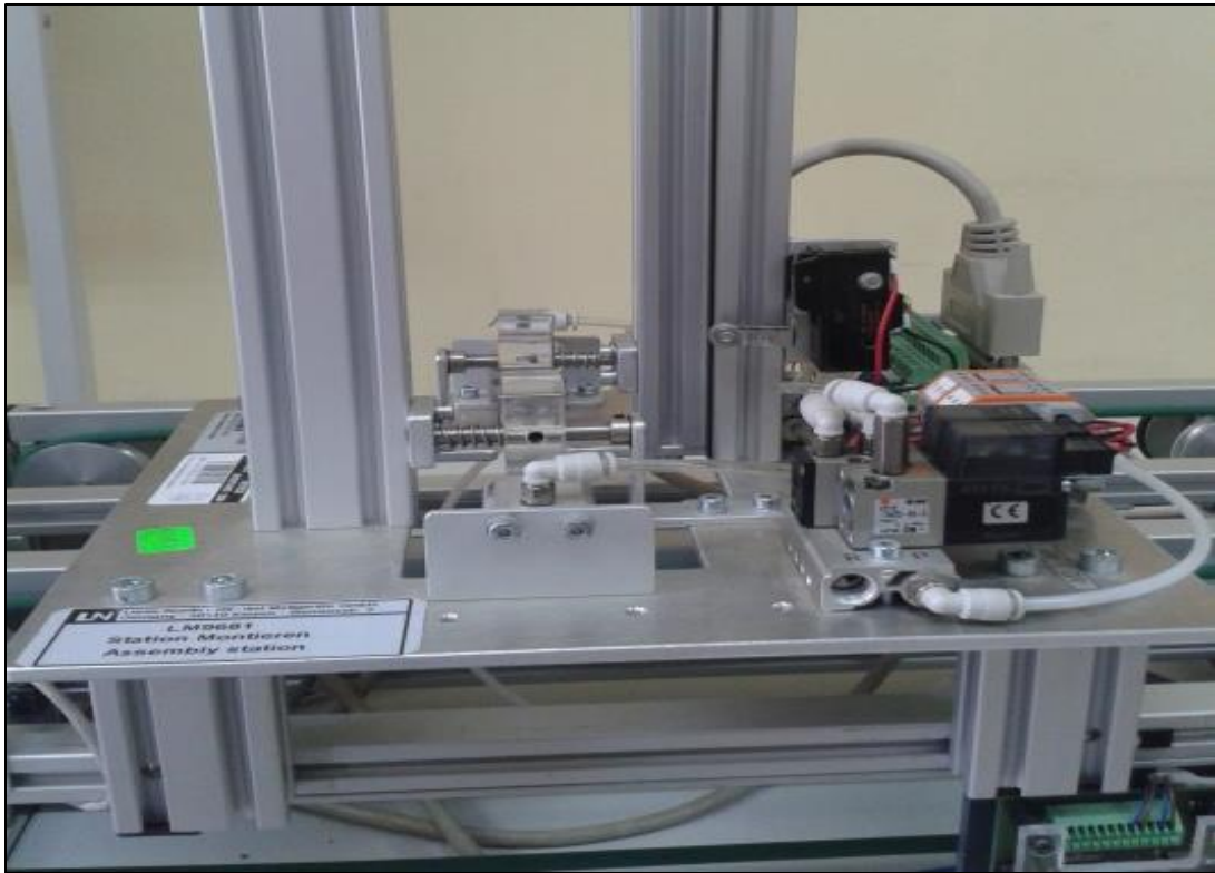
Figura 27. Instalación de la estación de montaje
