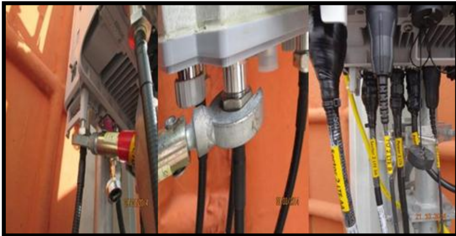
FIGURA N° 3.23: TORQUE, ENCINTADO Y VULCANIZADO DE LOS JUMPERS
