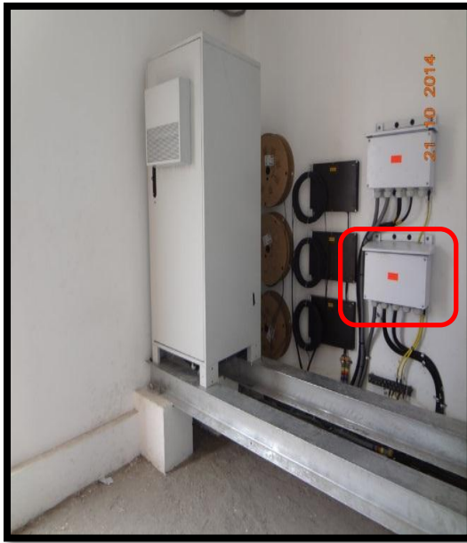
FIGURA N° 3.25: UBICACIÓN DE NUEVO BY PASS PARA 4G.
