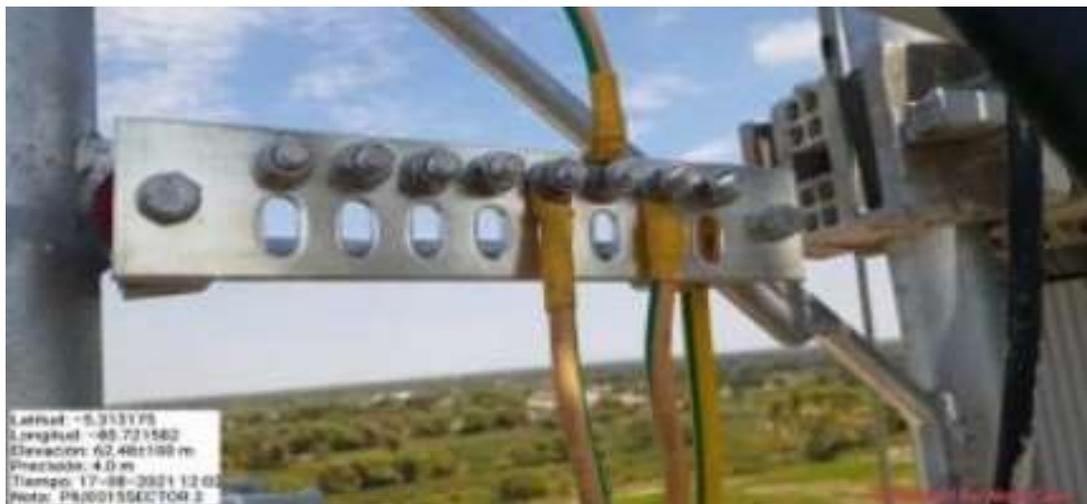
*Figura 3.22.* Aterramiento de ODU en la Torre.
