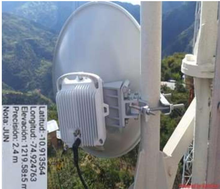
*Figura 3.20.* Antena Modelo SB1-127CIPN Instalada en la Torre.
