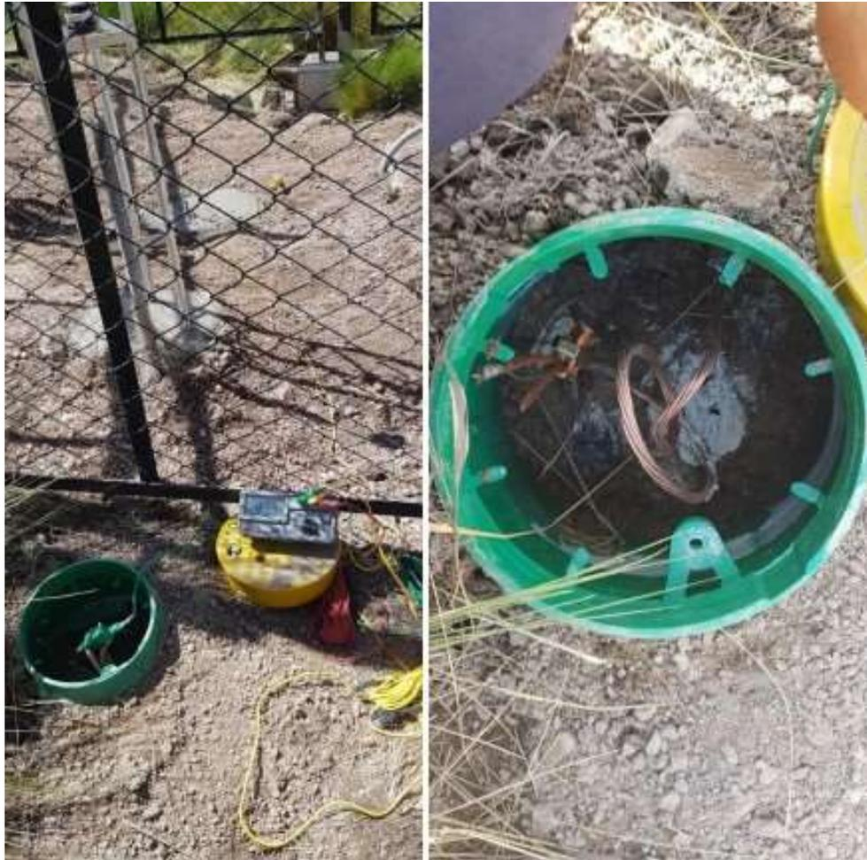
*Figura 3.28.* Instalación de Pozo a tierra.
