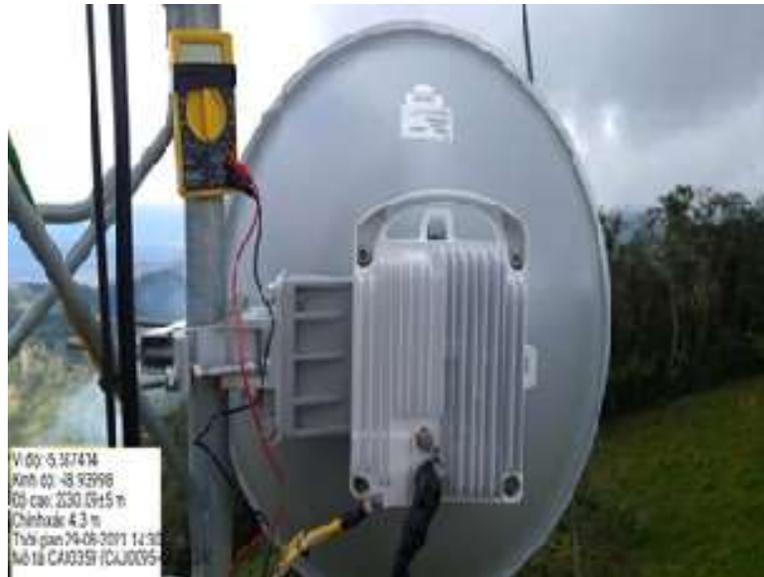
Figura 3.42. Medición de Voltaje.
