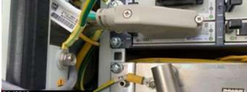
*Figura 3.40.* Aterramiento de Equipos.
