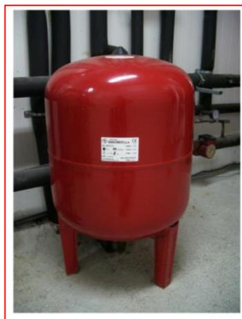
**Figura 28.** Vaso de expansión en una instalación solar térmica, Fuente: Mecalia energy sistem
