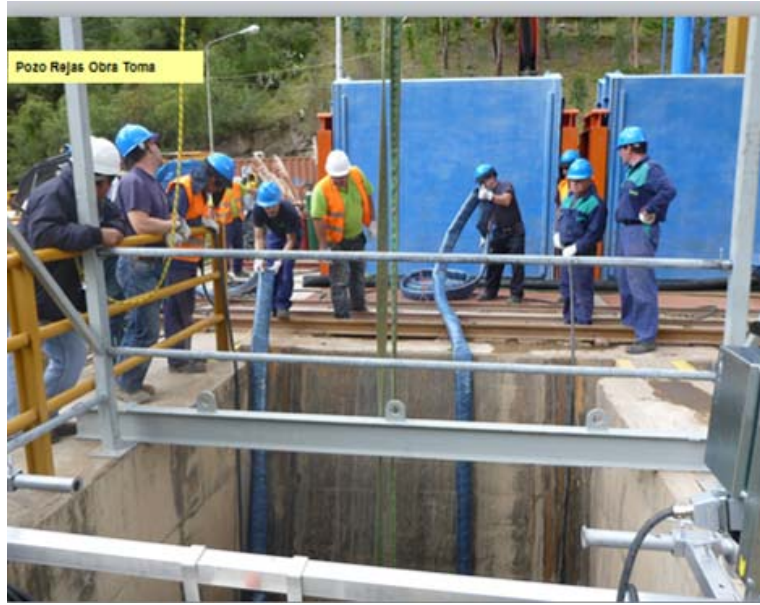
Pozo de reja de Obra Toma Nave A.
