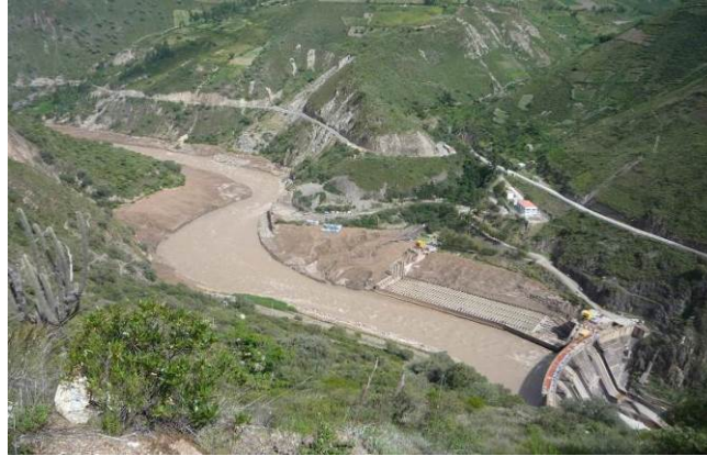
Figura 1: Vista panorámica de la Presa Tablachaca
