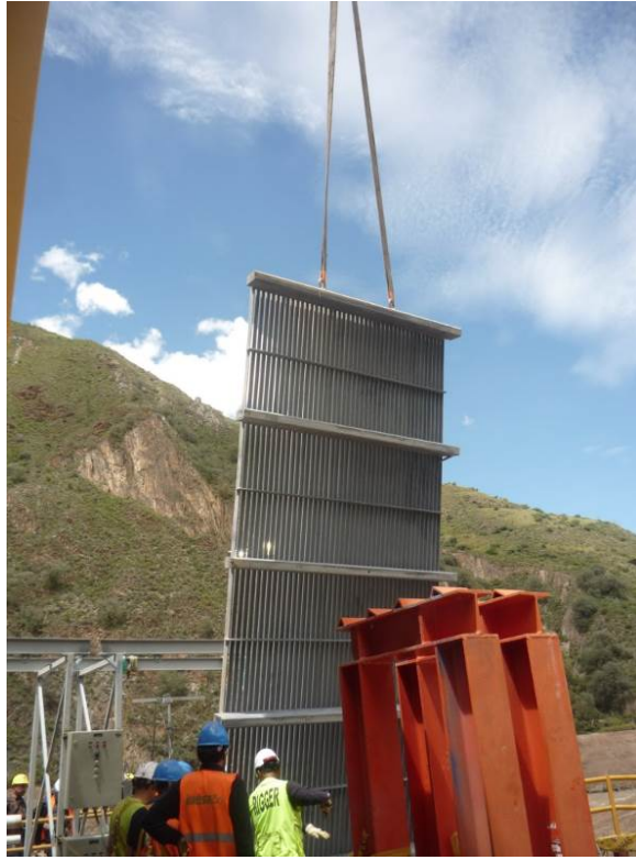
Colocacion de la reja nueva en la Nave A
