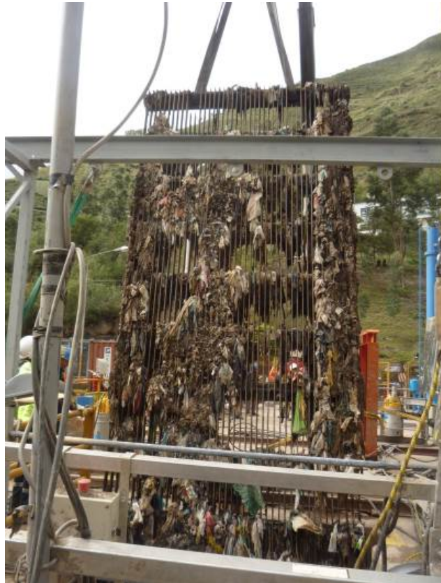
Extracciòn de la Reja Antigua de la Nave A
