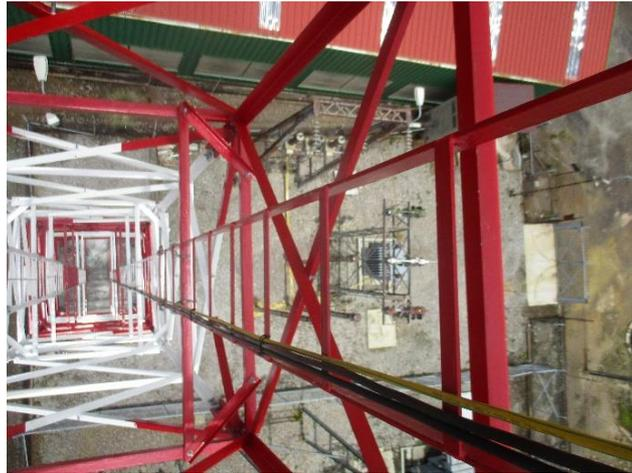
Fotografía 40. Ajuste de cable IF en el recorrido por la torre
