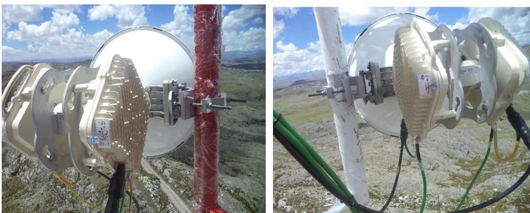
Fotografía 45. Instalación de antena y ODU en Cerro Jaital
