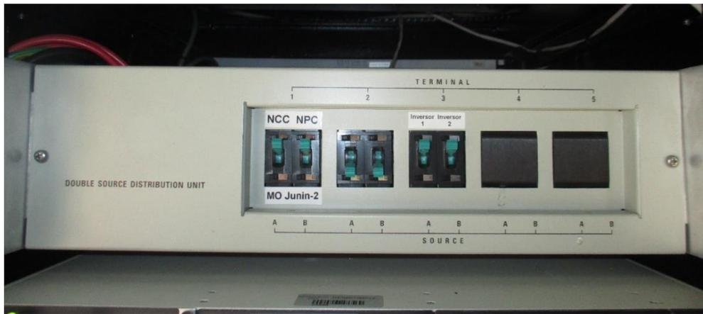
Fotografía A2 5. Distribuidor de energía -48Vdc
