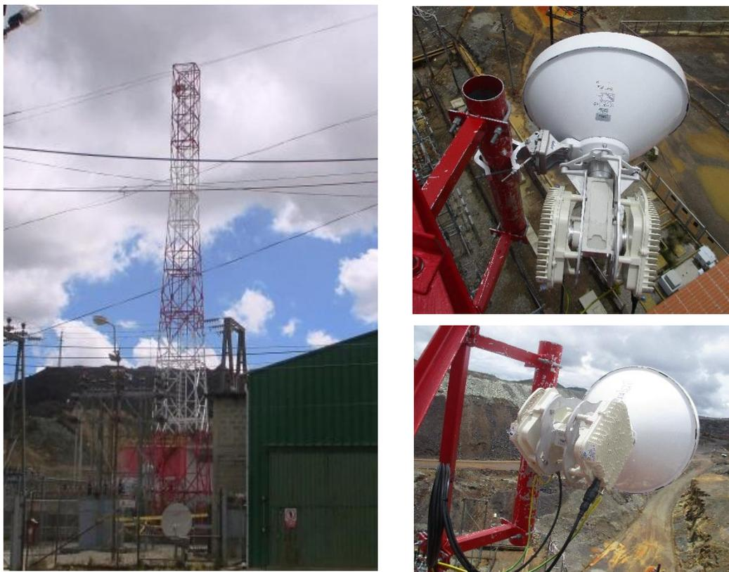
Fotografía 49. Instalación de antena y ODU en SE Excelsior
