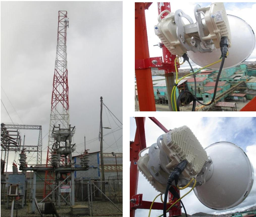
Fotografía 47. Instalación de antena y ODU en SE Paragsha
