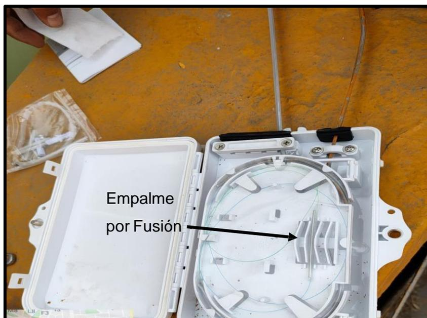
Figura 47: Fusión de los extremos " A" Y "B" cable de fibra óptica en caja de empalme.
