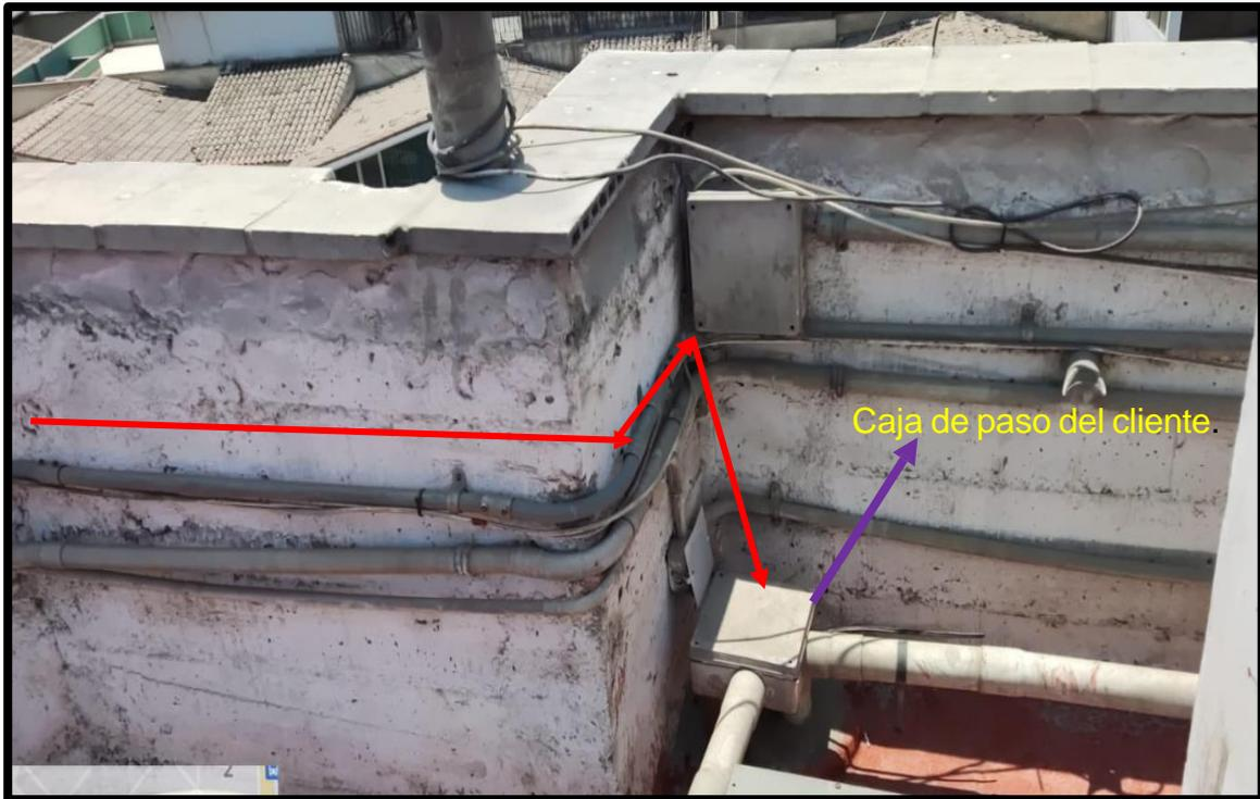
Figura 54: Fibra óptica siguió recorrido por tubo metálico hasta ingresar por caja de paso.
