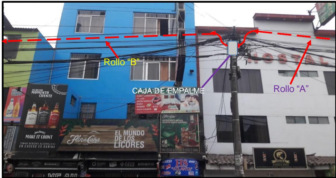
Figura 48: Detalle de poste 06 TDP, instalación caja de empalme
