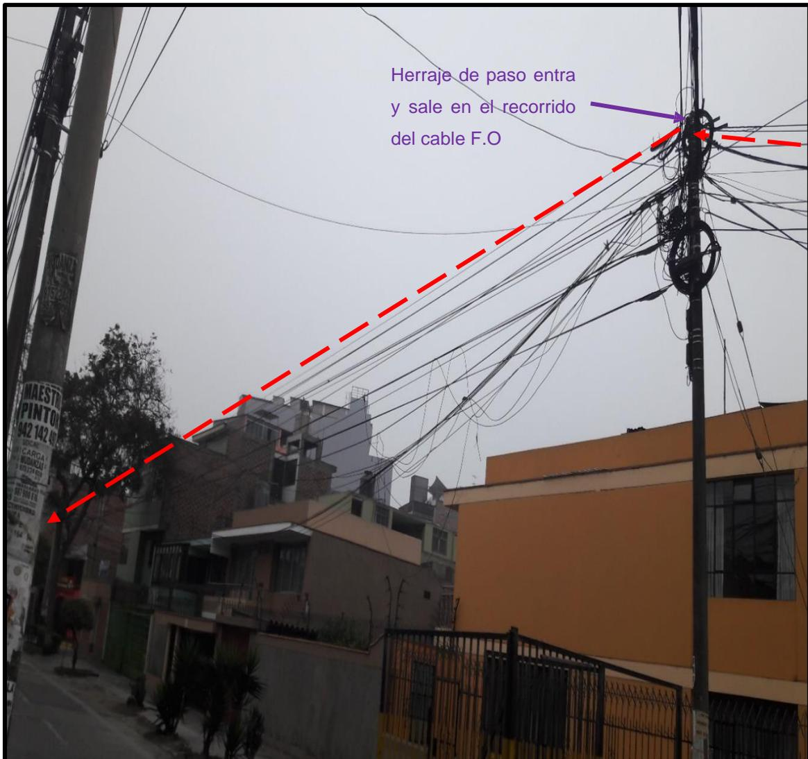
Figura 43: Poste 02, recorrido del cable de fibra óptica
