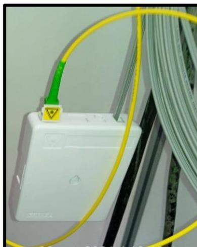
Figura 56: Roseta óptica instalada
