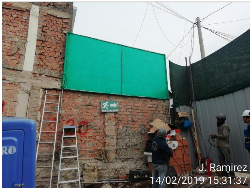
*Figura 5.* Instalación de mallas antipolvo en cercos perimetrales de la obra Residencial Mendiburu 642.
