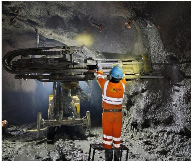
*Nota.* Los trabajos rutinarios se inician con la medición de angulamiento del brazo para la iniciación de la perforación. Elaboración propia
