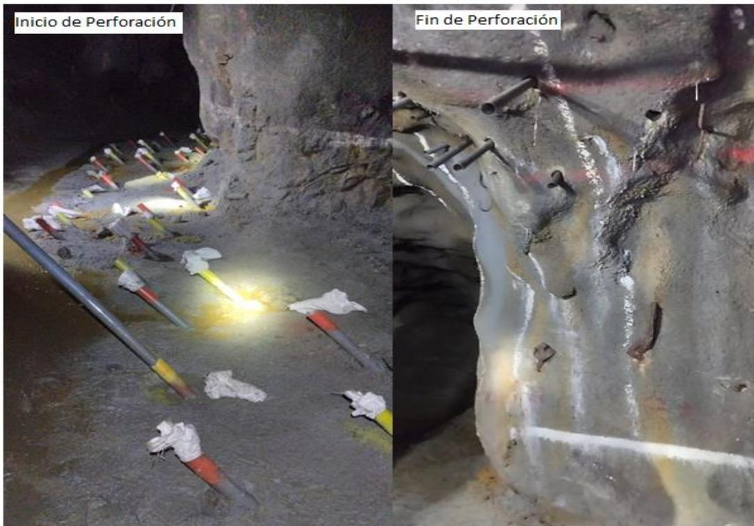
*Nota.* La perforación se inicia en una cámara superior y finaliza en una cámara inferior, estableciendo así un recorrido vertical a través de la formación geológica. Elaboración propia.
