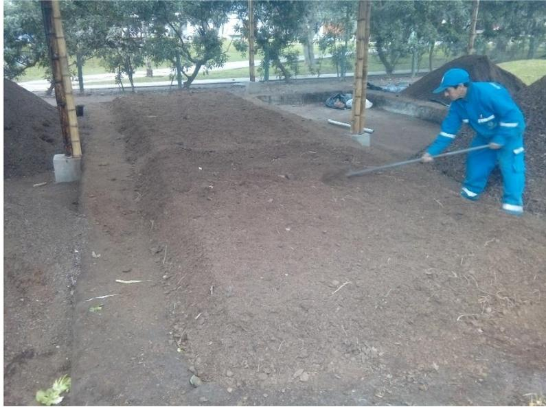
**Ilustración 6:: Armado de la 2° capa de residuos orgánicos del "Multimercado San Borja"**
