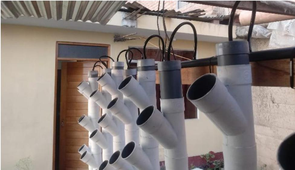
**Figura 37.** Colocación de los tubos de 5mm a las columnas.
