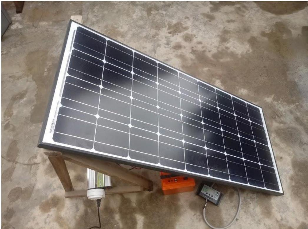
**Figura 38.** Sistema fotovoltaico (aislado) armado con sus componentes. Elaboración propia.
